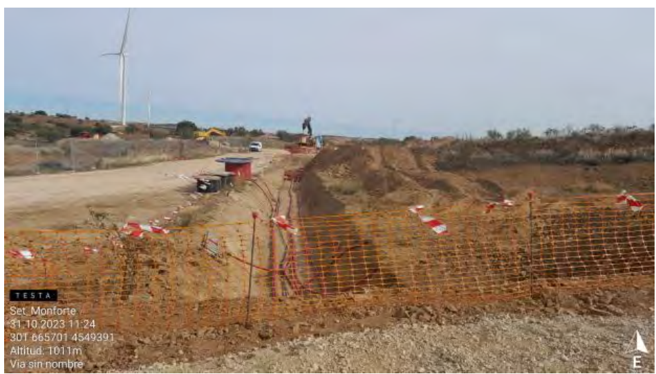
Tendido de cable en tramo SET monforte.
