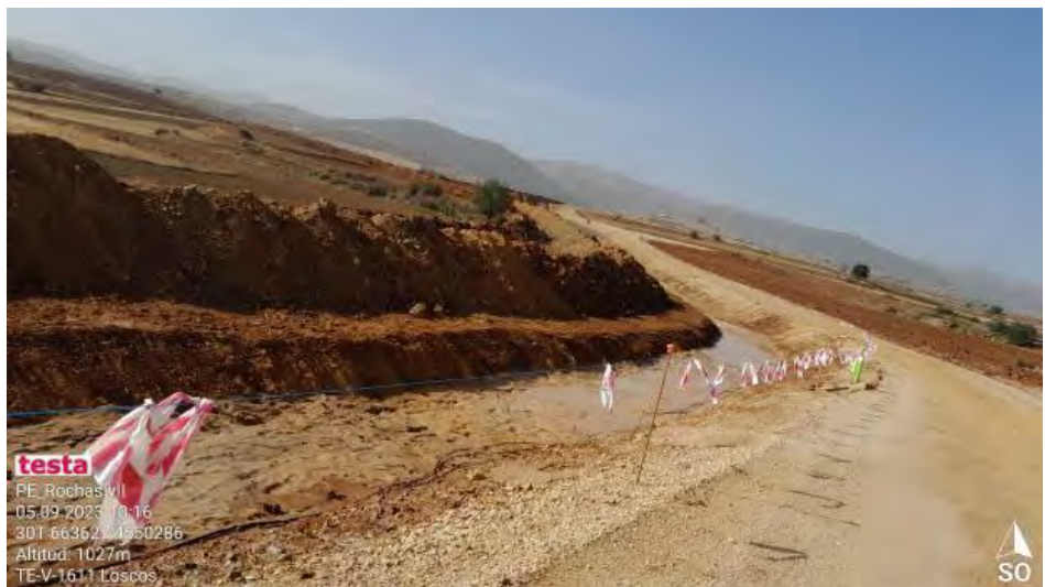
Zanja de evacuación tras las lluvias.
