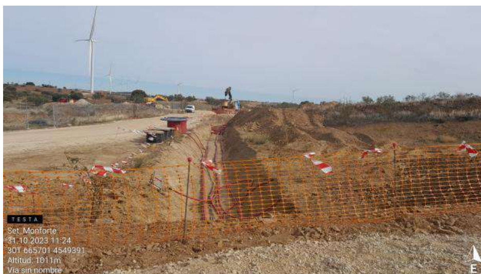
Tendido de cable en tramo SET monforte.
