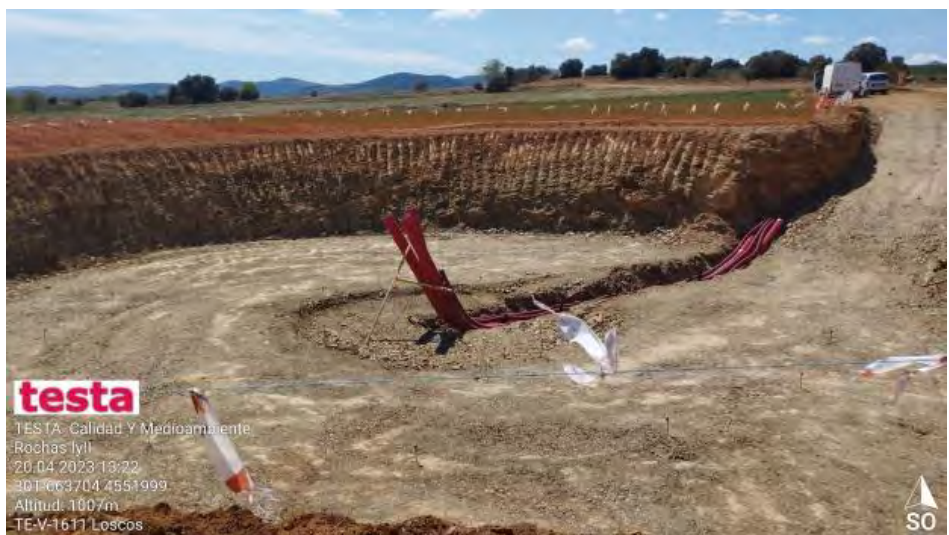
Avances en excavaciones
