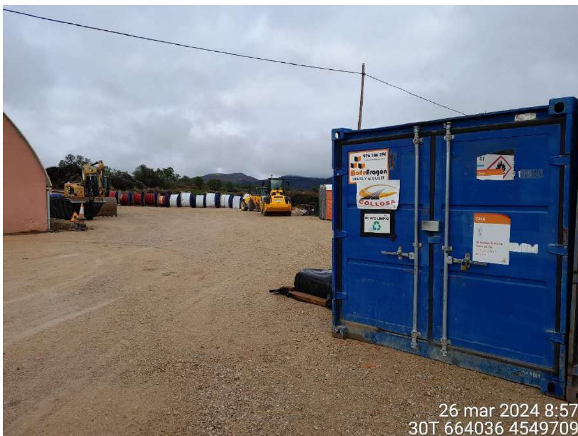
Contenedor en punto limpio de la campa
