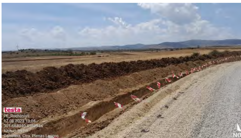
Separación de tierras en zanja de evacuación.
