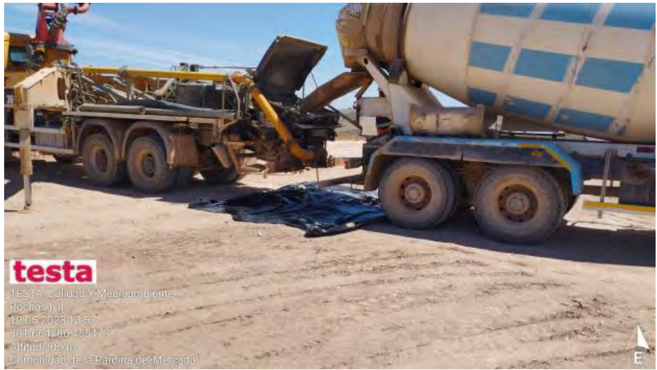
Descarga de hormigón correcta
