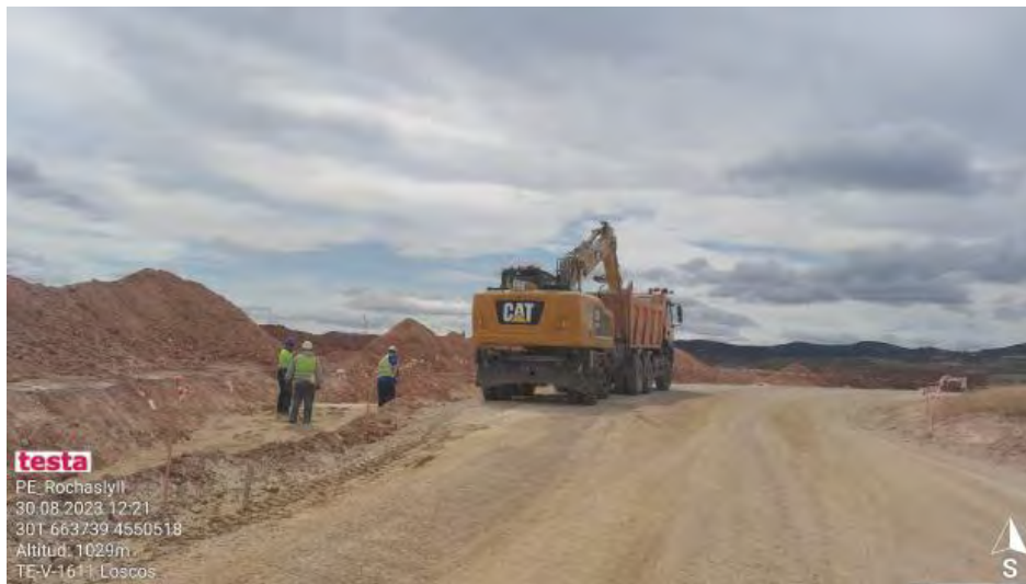
Extendido de cable en zanja de evacuación.
