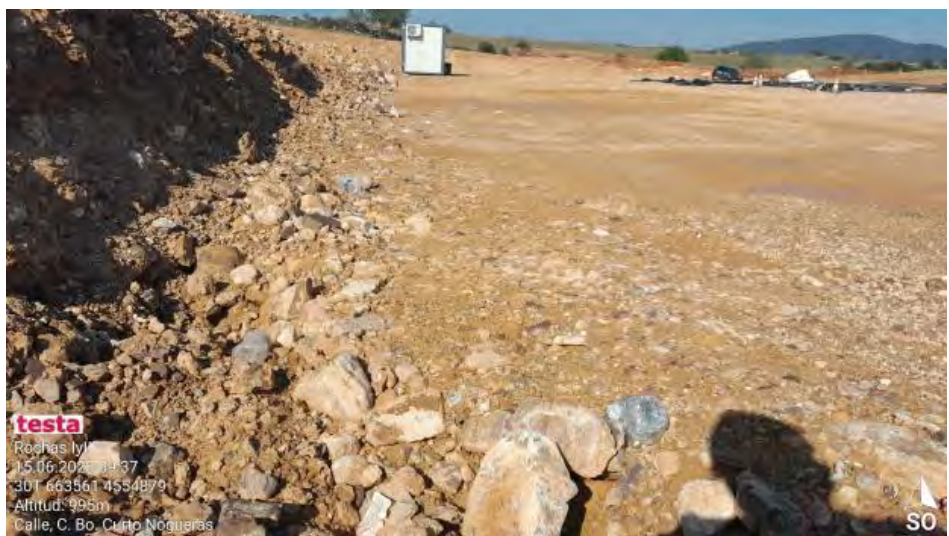
Residuos en plataforma.
