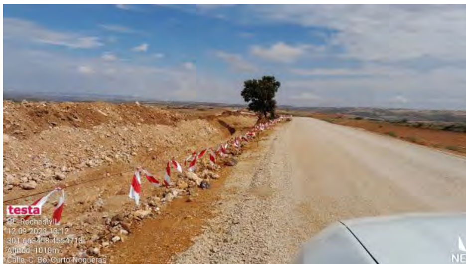
Zanja de evacuación ,separación de tierras.
