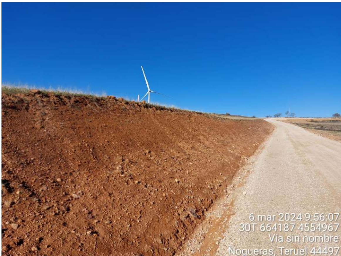
Talud vial Rocha I tras restauración ambiental
