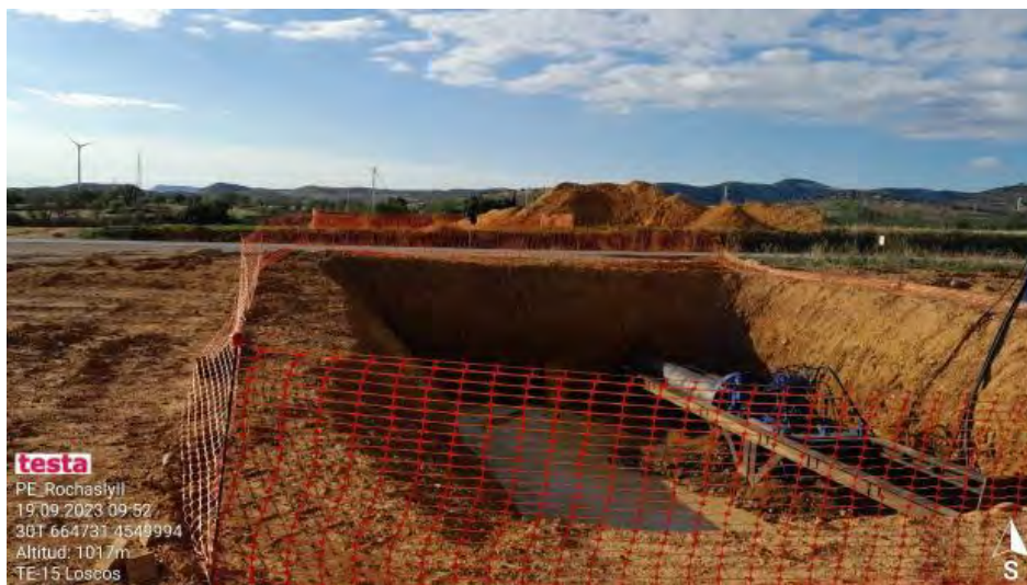
Paso de línea de evacuación bajo calzada.
