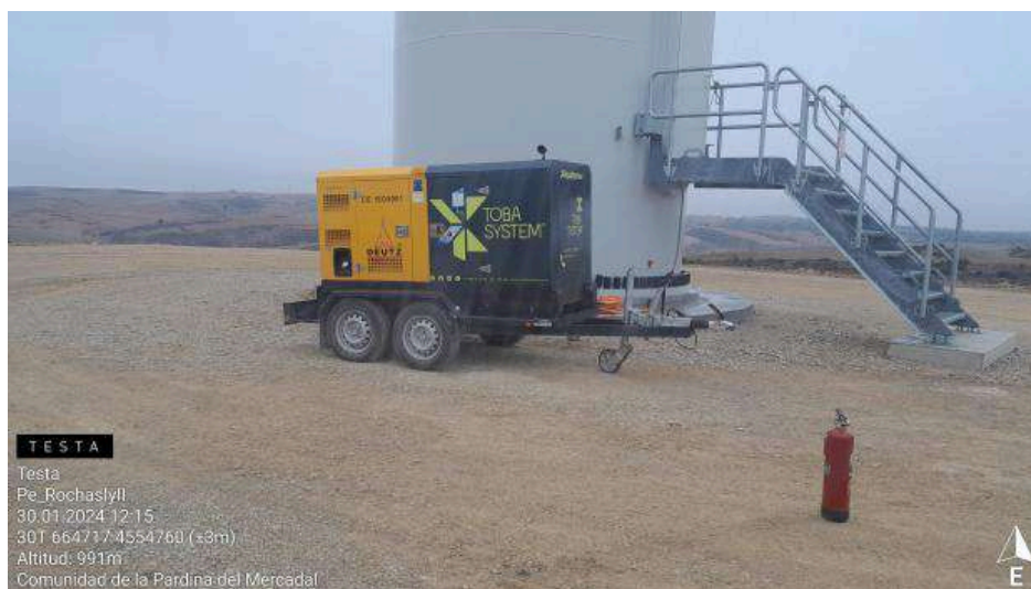
Generador sin protección de suelos en RH1-7
