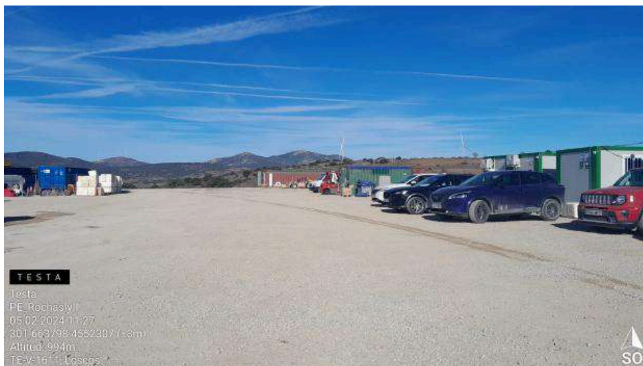
Desmantelamiento de carpa en camp RH1
