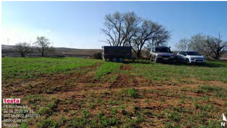
Vehículo de repostaje sin la adecuada protección de suelo . Se indica que se subsane .
