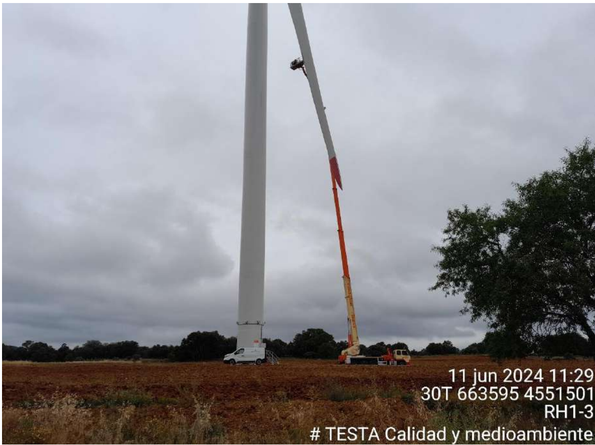
Imagen 1. Revisión de palas en la Plataforma RH1-3
