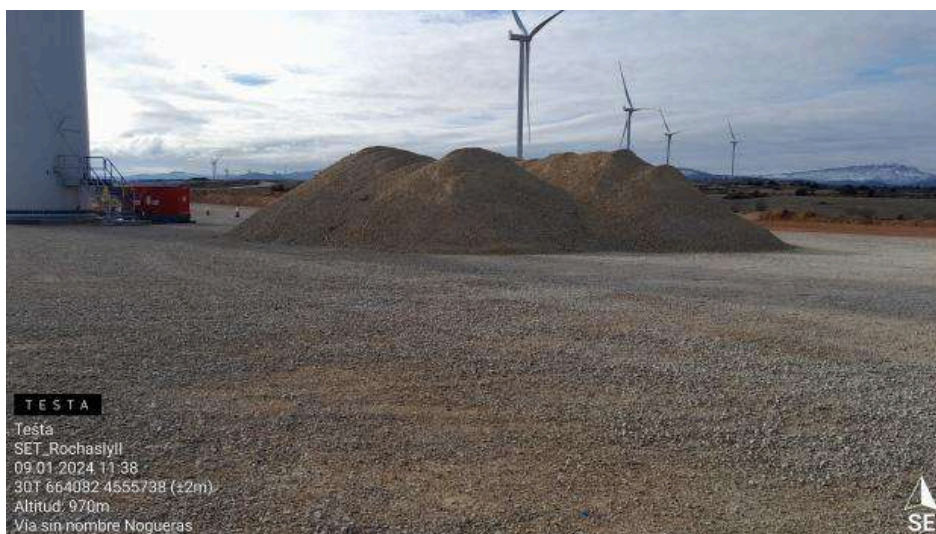
Retirada de zahorra en plataforma RH1-8
