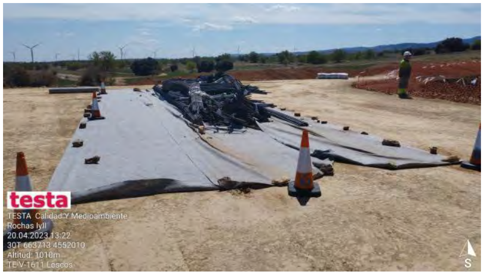
Acopio de hierros zapata.
