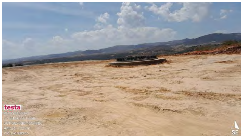
Recogida de grout en RH1-4.
