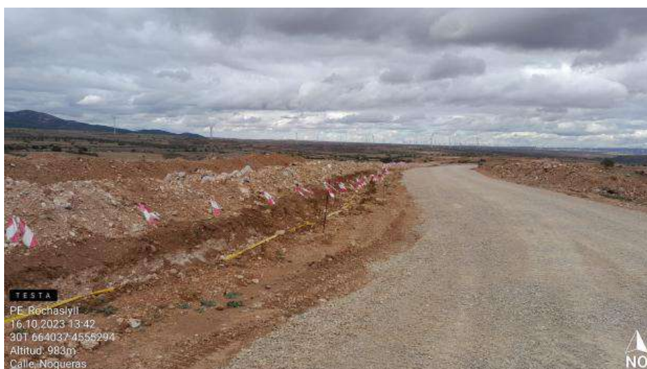
Zanja de evacuación
