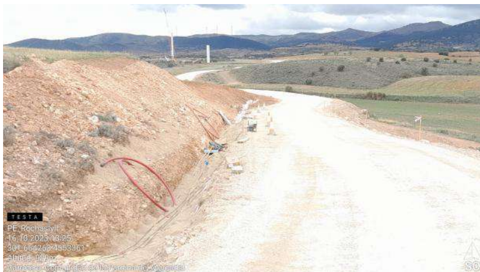
Generador sin protección de suelo
