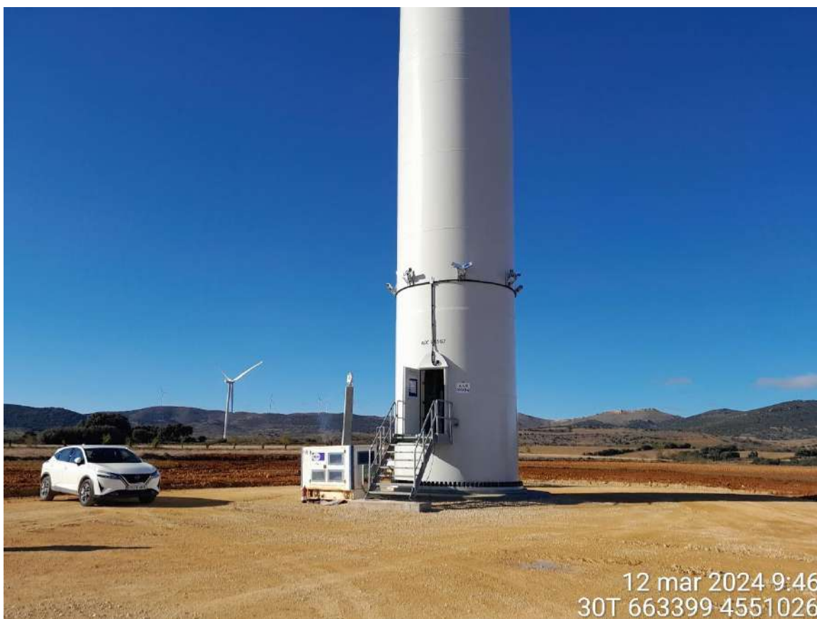
Inspección puesta a punto en RH1-02
