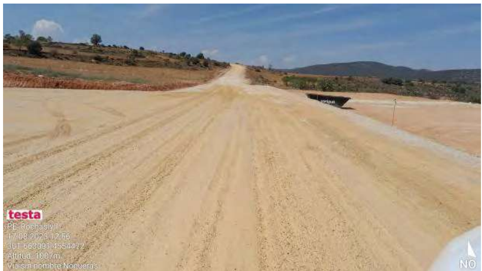
Riegos en viales y plataformas
