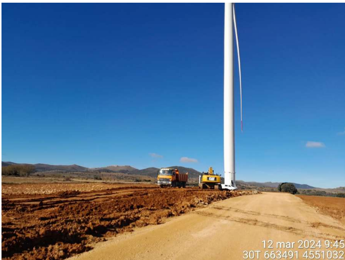
Maquinaria pesada realizando labores de movimiento de tierras en RH1-02 para restauración ambiental
