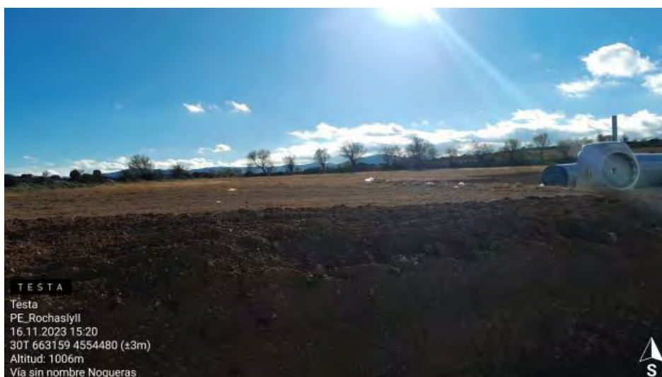
Residuos y materiales esparcidos debido a las fuertes rachas de viento en RH1-5.
