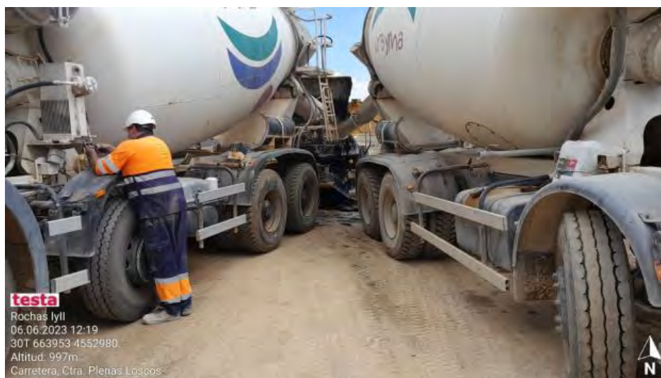
Aislamiento de suelo en bombeo de hormigón
