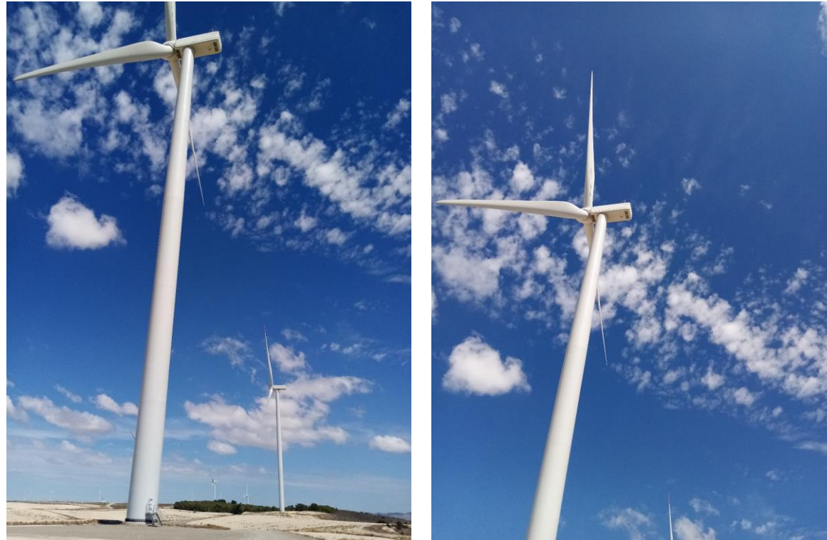
Fotografías 3 a 4: Barquillas de los aerogeneradores sin derrames de aceite
