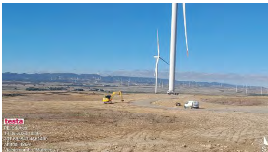
trabajos en cunetas
