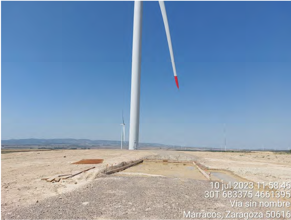
Imagen 1. Vial hacia OBIII-01 en el que todavía deben realizarse trabajos.
