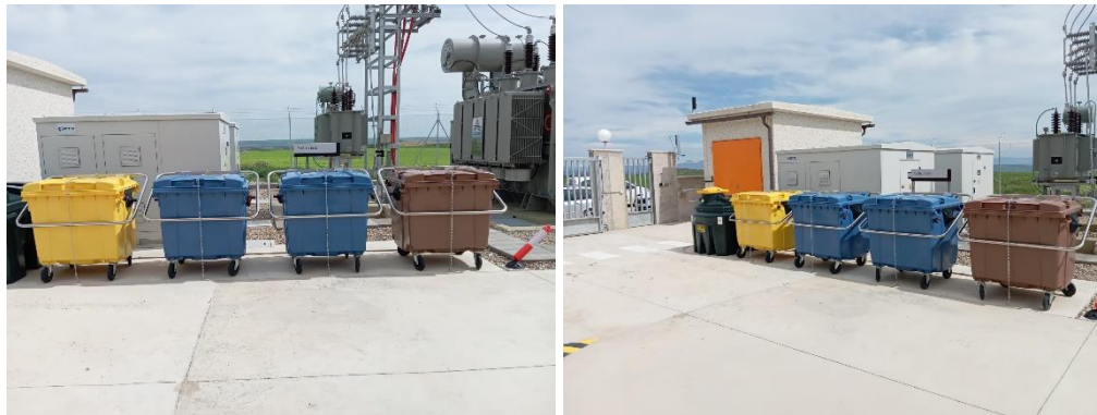
Fotografías 23 a 24: Almacenamiento de residuos
