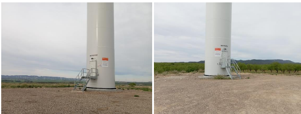
Fotografías 12 a 13: Señalización de las torres de los aerogeneradores
