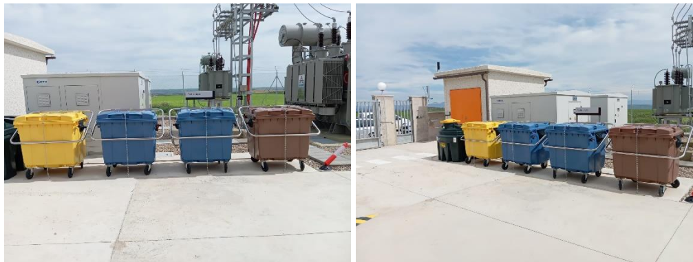
Fotografías 23 a 24: Almacenamiento de residuos
