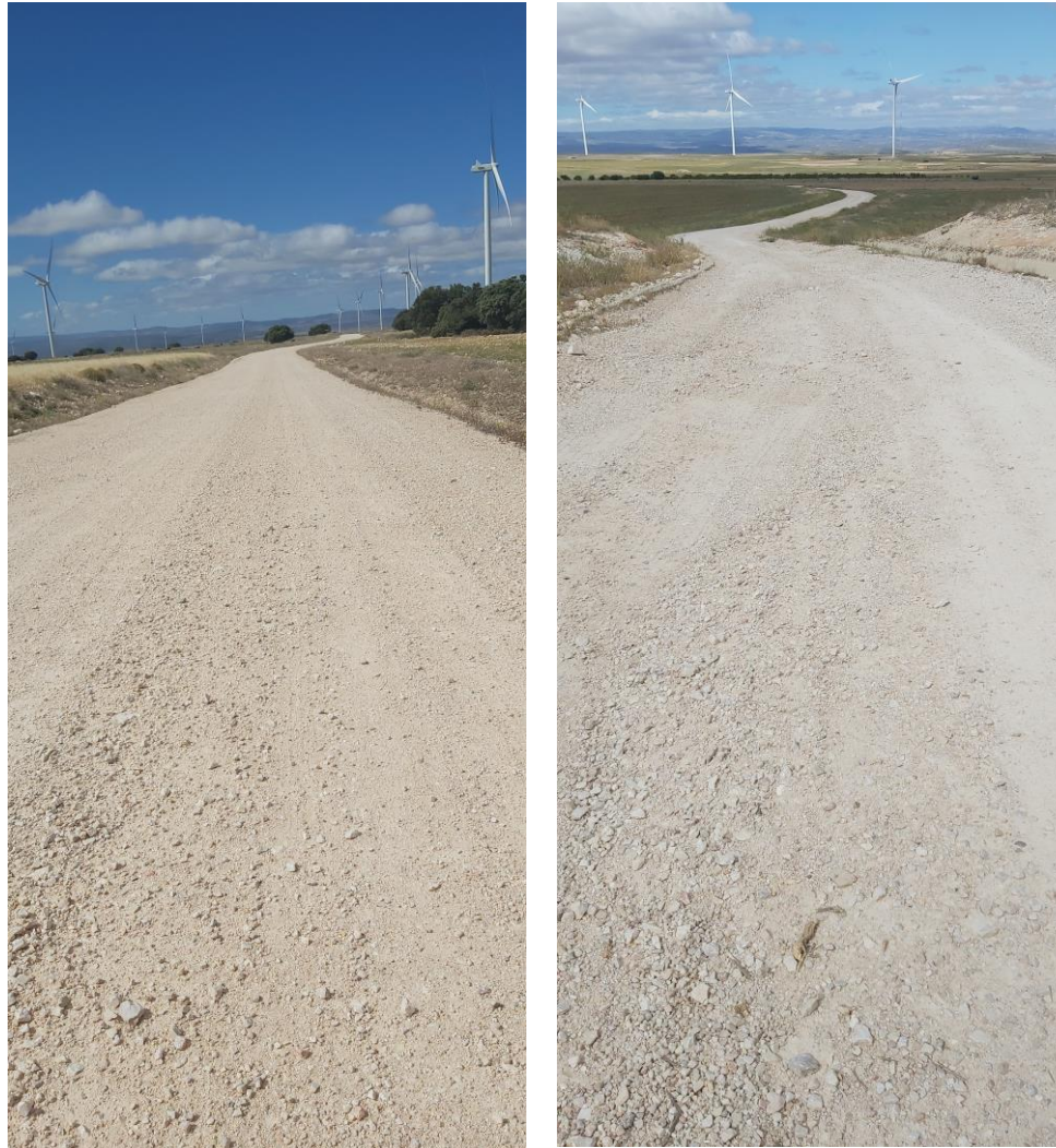
Fotografías 4 y 5: Estado de los caminos y viales
