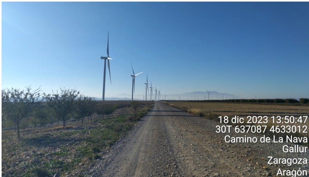
Figura 43: Vial de acceso a la altura de aerogenerador MU-06, MU-07 y MU-08.
