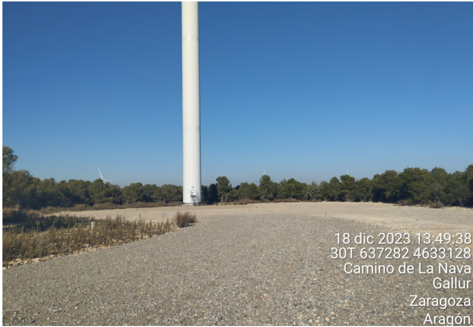
Figura 42: Plataforma de MU-08 localizada en el interior del pinar de repoblación.
