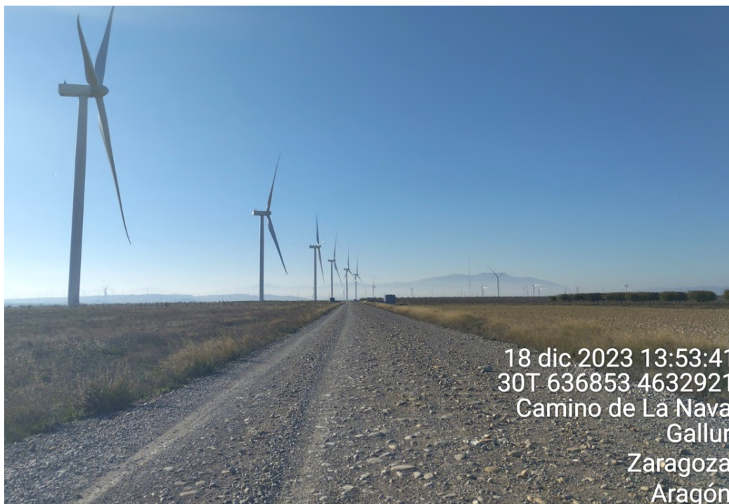
Figura 46: Vial de acceso a la altura de aerogeneradores MU-07 y MU-06.
