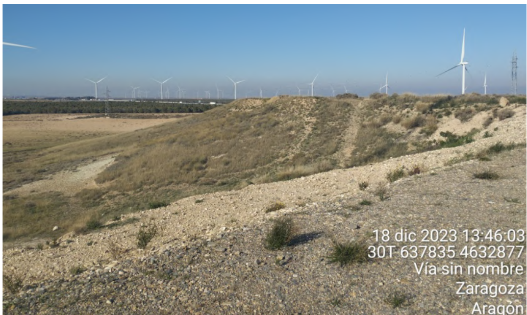
Figura 38: Talud noreste de MU-09, en correcto estado de conservación.
