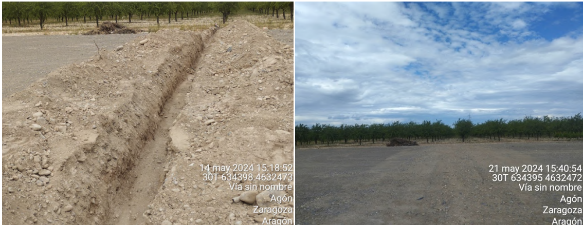
Evolución de los trabajos de excavación y posterior soterrado de un drenaje de PVC en la plataforma de Multitecnología extensión en mayo de 2024.
