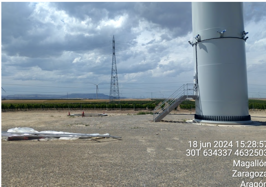
Brida metálica y piezas sobrantes de la escalera de la base del aerogenerador, pendientes de su retirada de obra.
