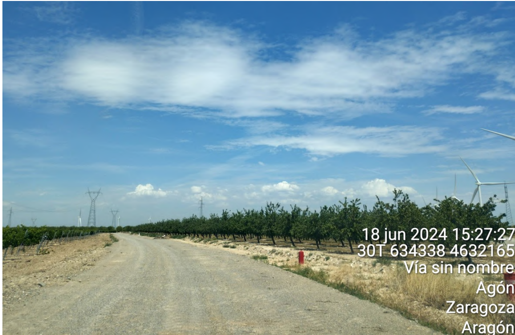
Tramo sur del vial de acceso al aerogenerador de Multitecnología extensión
