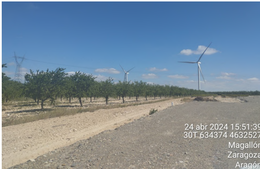
Fotografía del tramo soterrado paralelo a límite norte de plataforma del aerogenerador de Multitecnología Extensión, que transcurre sobre un cultivo arbóreo de almendros y viñas.
