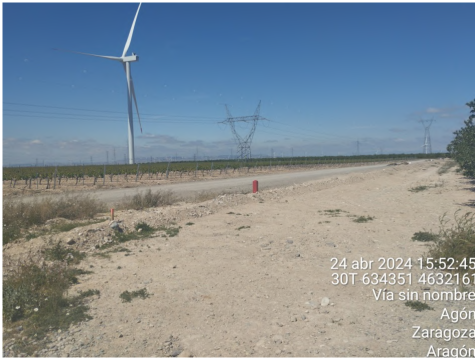
Tramo soterrado en el tramo más sur del vial de acceso al parque eólico.
