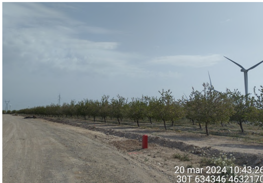
Tramo soterrado en el tramo más sur del vial de acceso al parque eólico.
