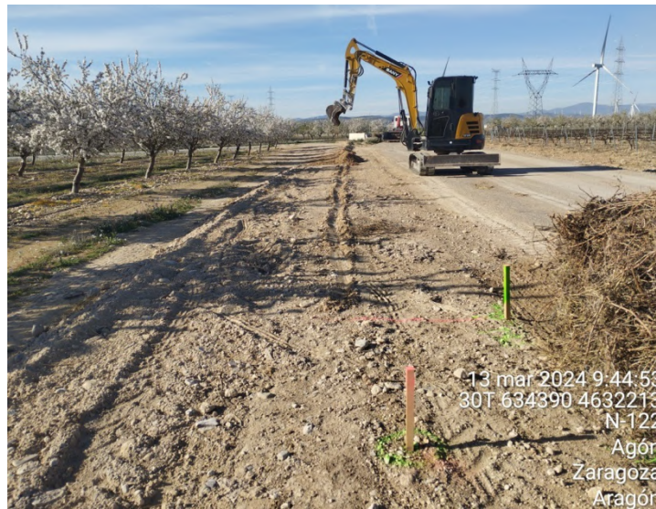
Excavadora apartando material y nivelando área de polígono agrario aledaño al vial de acceso al parque eólico a 13 de marzo de 2024.
