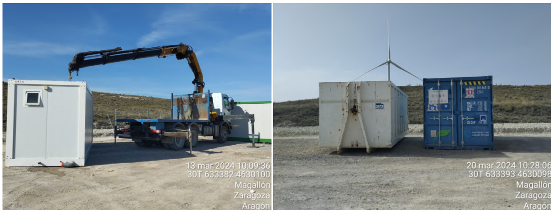
Desmantelamiento del Site Camp el 20 de marzo de 2024, permaneciendo en obra sólo el punto limpio de residuos de la obra.
