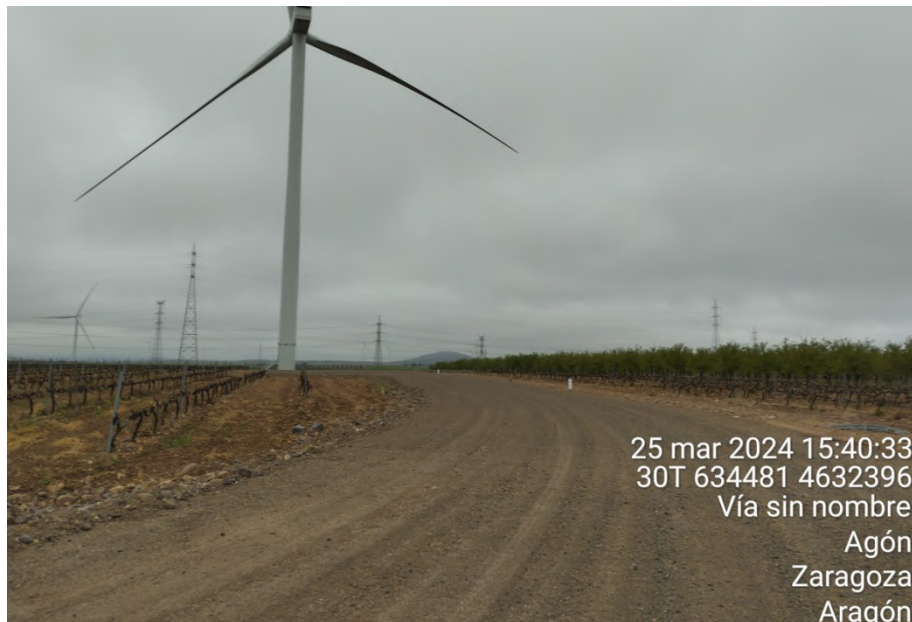
Tramo norte del vial de acceso al aerogenerador de Multitecnología extensión.
