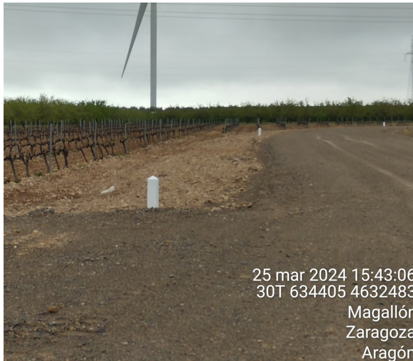
Tramo soterrado paralelo al vial de acceso de Multitecnología Extensión, en su tramo norte.
