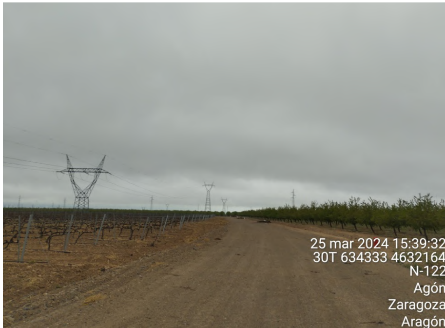
Tramo sur del vial de acceso al aerogenerador de Multitecnología extensión
