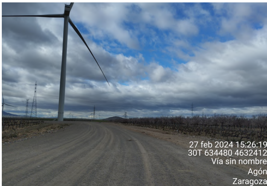
Tramo norte del vial de acceso al aerogenerador de Multitecnología extensión.
