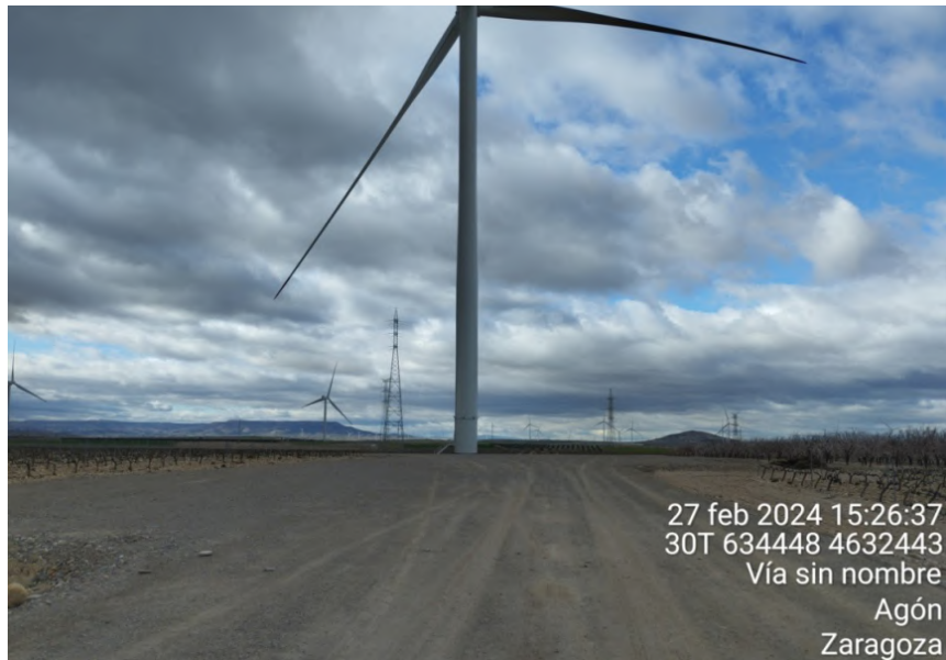
Plataforma de Multitecnología extensión completamente terminada y despejada a febrero de 2024.
