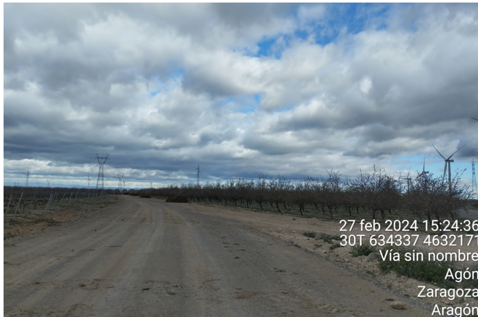
Tramo sur del vial de acceso al aerogenerador de Multitecnología extensión
