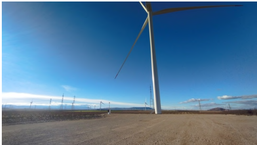
Plataforma de Multitecnología extensión completamente terminada y despejada a enero de 2024.
