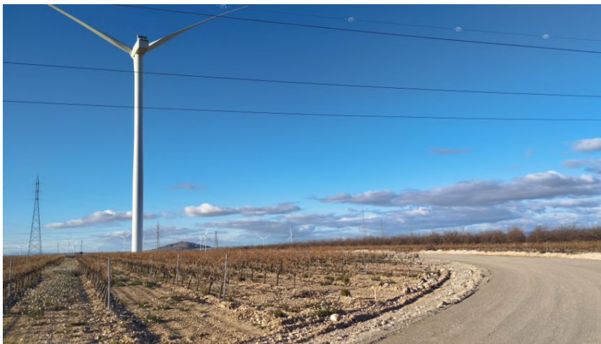
Tramo norte del vial de acceso al aerogenerador de Multitecnología extensión.
