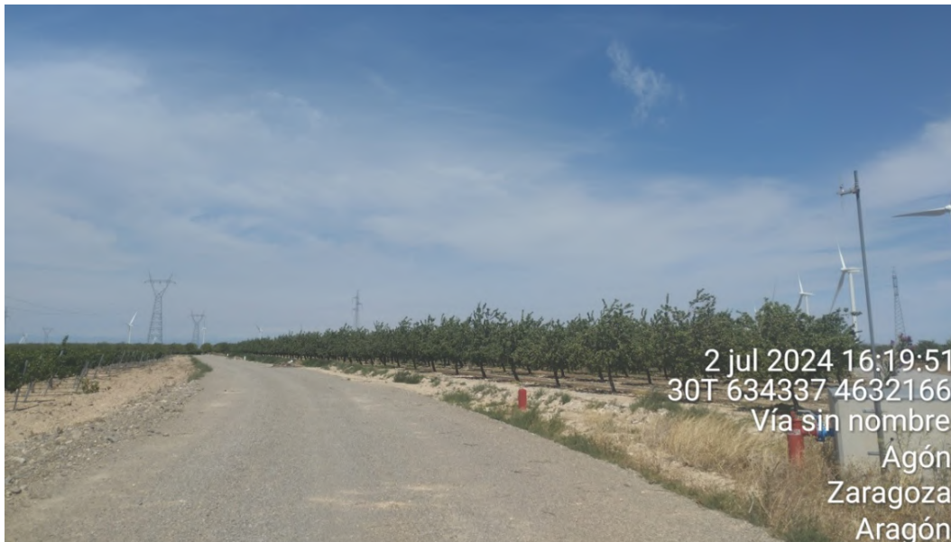
Tramo sur del vial de acceso al aerogenerador de Multitecnología extensión
