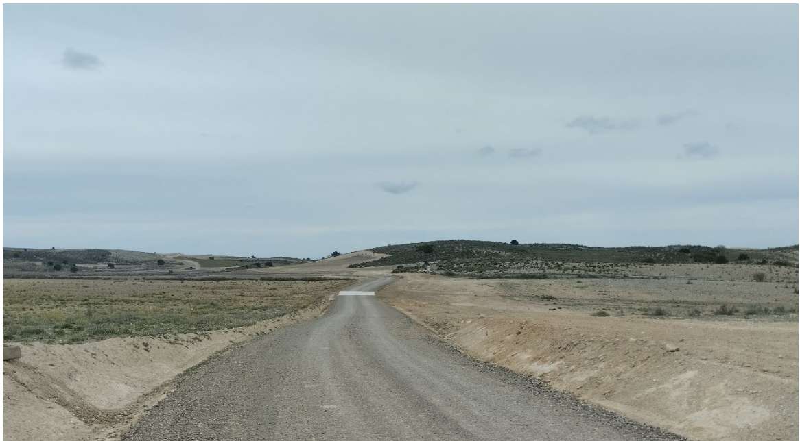
Situación a 25 de abril de 2024, tras el sexto mes de obras
