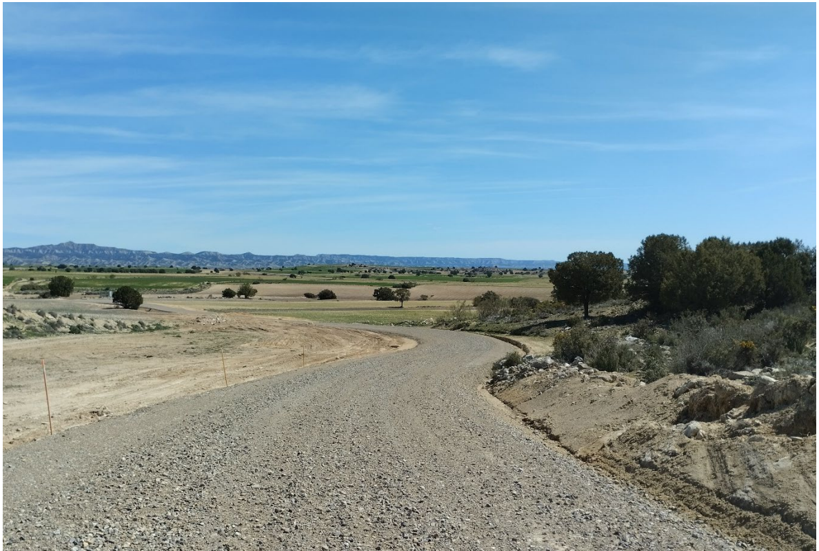
Situación a 4 de abril de 2024, tras el quinto mes de obras
