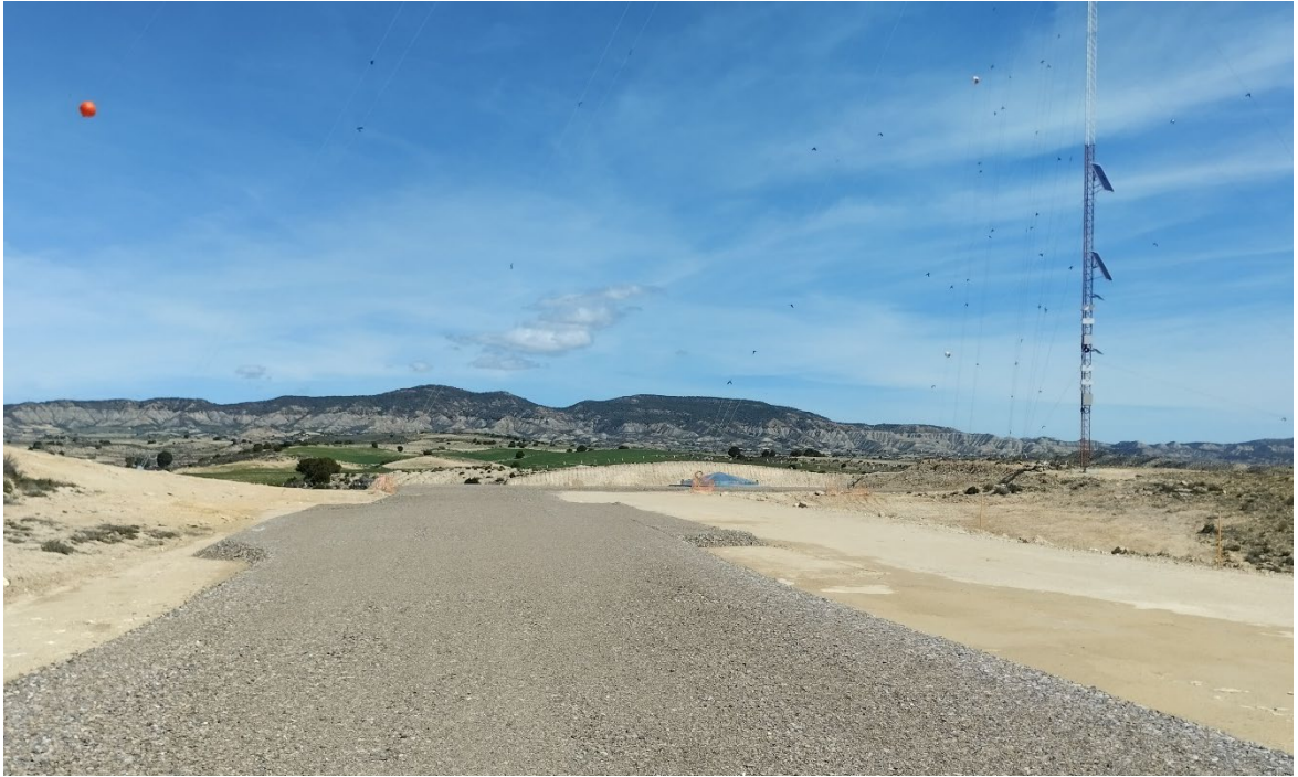
Situación a 4 de abril de 2024, tras el quinto mes de obras
