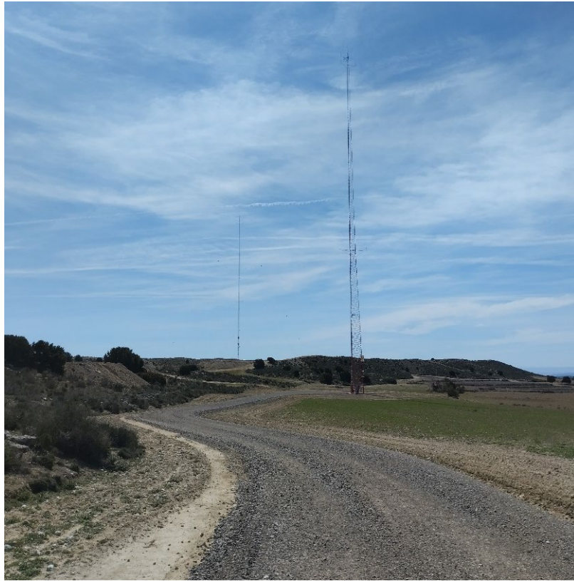
Situación a 4 de abril de 2024, tras el quinto mes de obras
