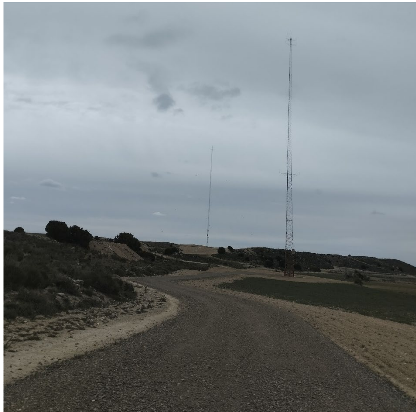
Situación a 25 de abril de 2024, tras el sexto mes de obras
