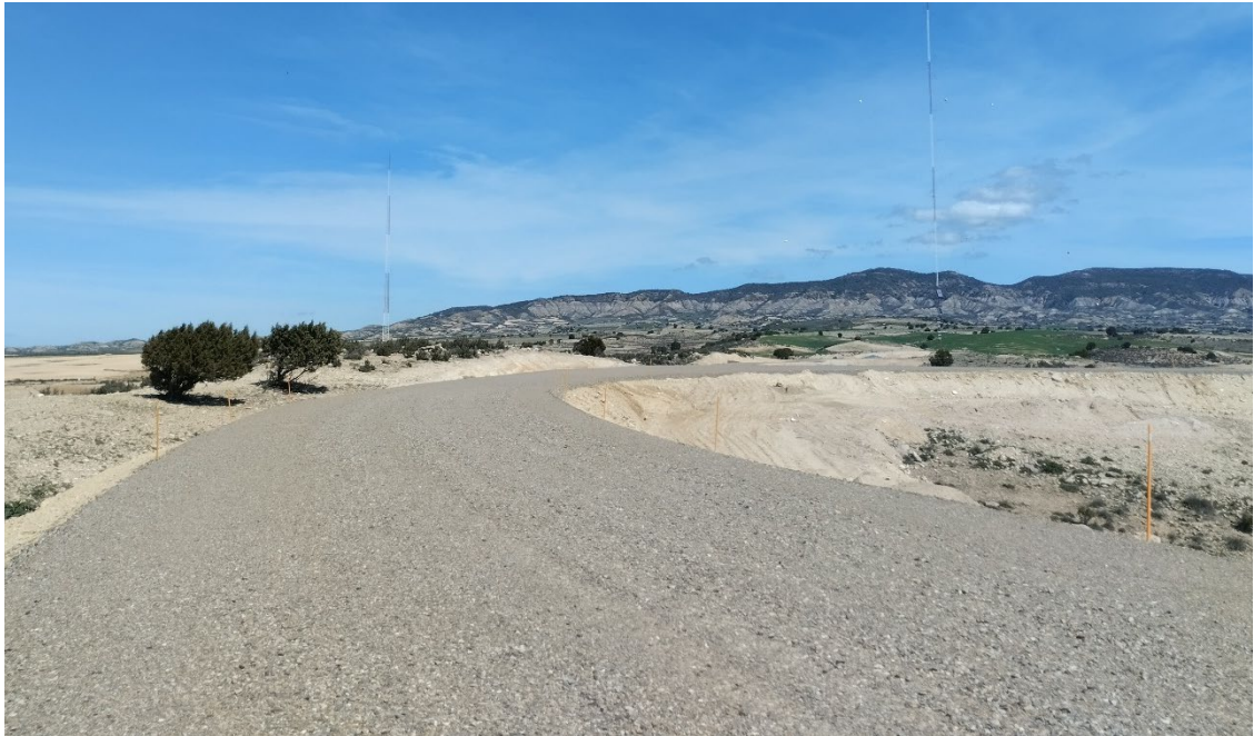
Situación a 4 de abril de 2024, tras el quinto mes de obras
