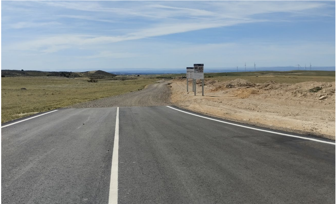
Situación a Situación a 4 de abril de 202 tras el quinto mes de obras
