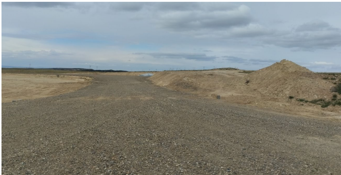
Situación a 25 de abril de 2022 tras el sexto mes de obras
