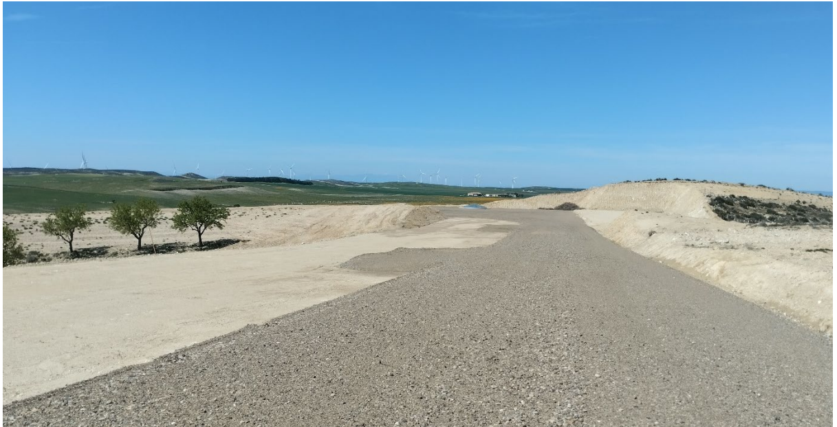
Situación a 4 de febrero de 2024, tras el quinto mes de obras
