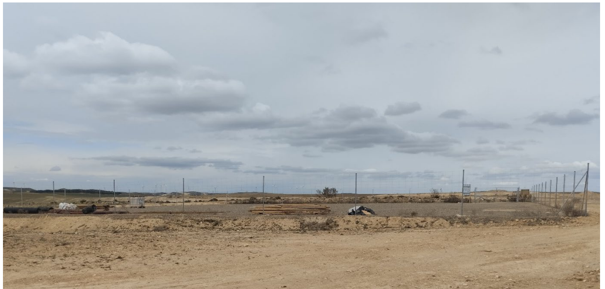
Situación a 25 de abril de 2024, tras el sexto mes de obras
