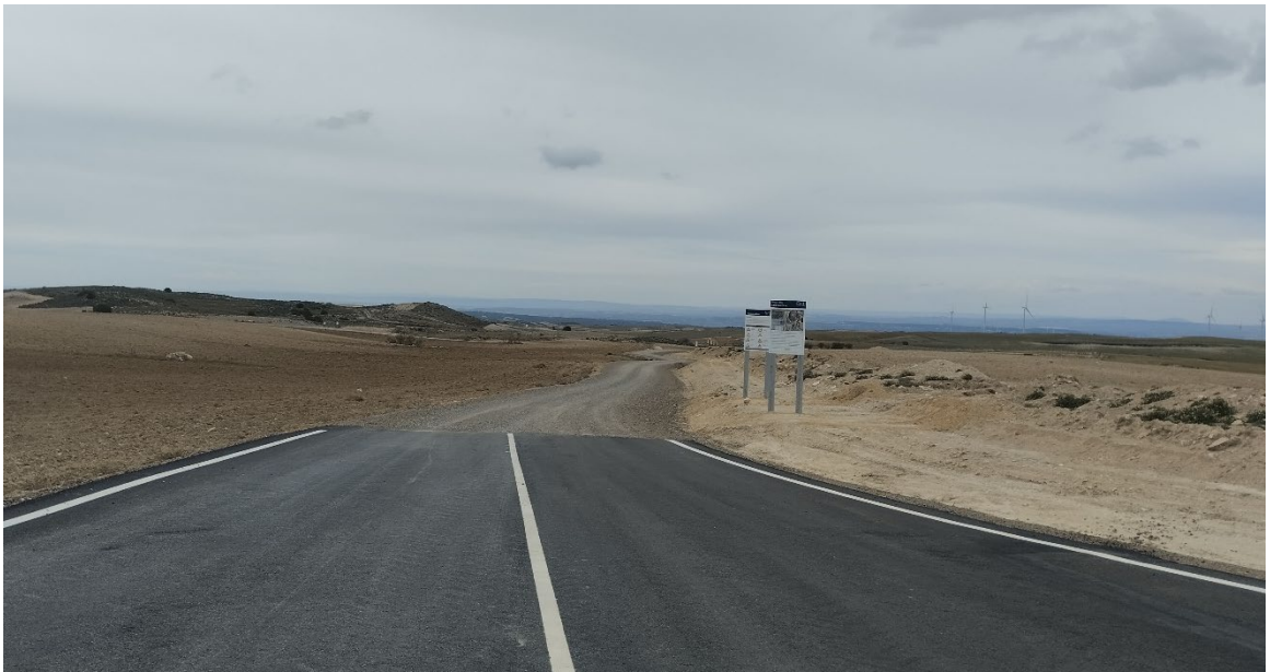
Situación a 25 de abril de 202 tras el sexto mes de obras
