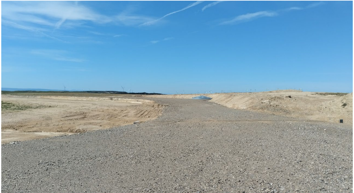
Situación a Situación a 4 de abril de 2022 tras el quinto mes de obras
