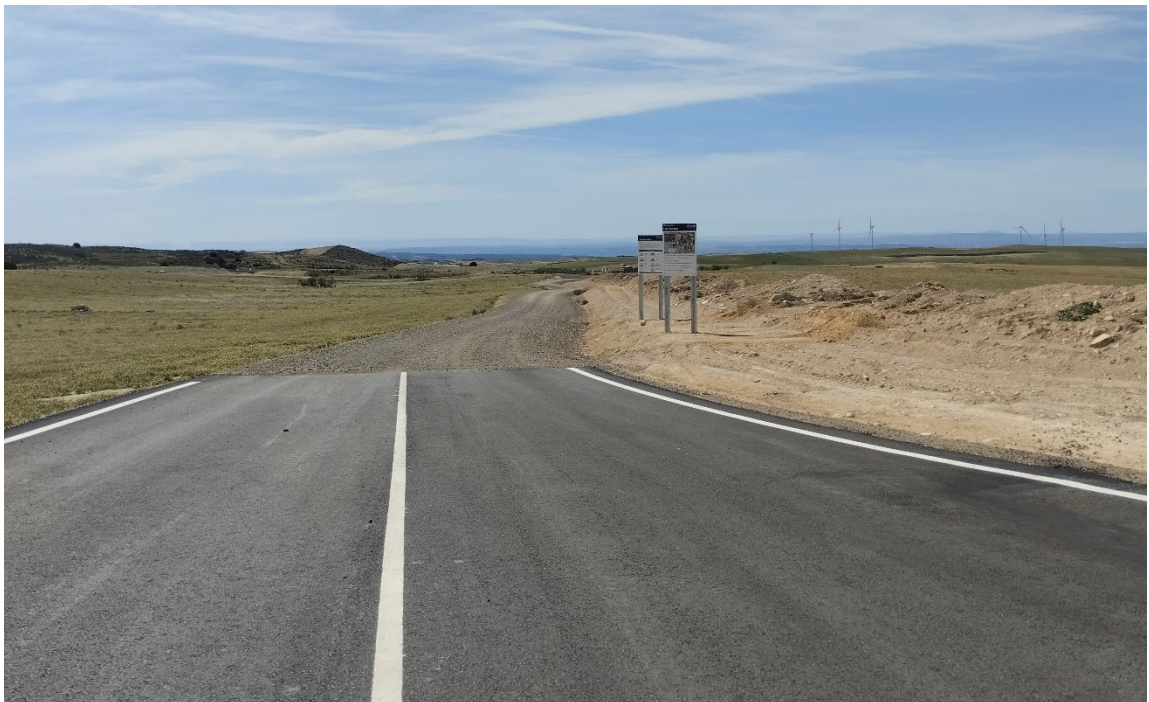
4, Situación a 4 de abril de 202 tras el quinto mes de obras
