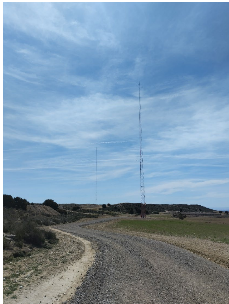
Situación a 4 de abril de 2024, tras el quinto mes de obras
