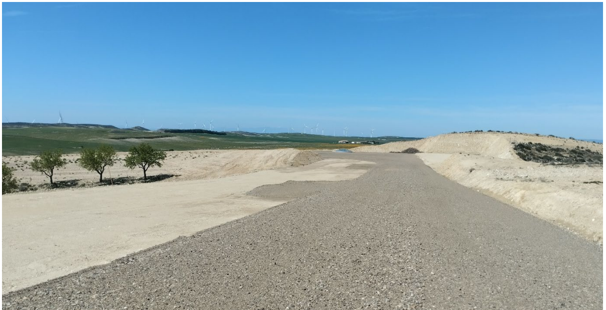
Situación a 4 de abril de 2024, tras el quinto mes de obras
