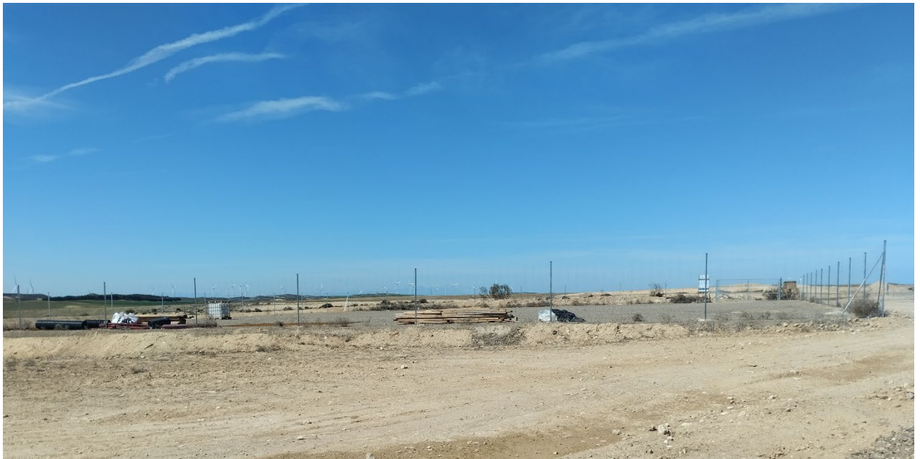
Situación a 4 de abril de 2024, tras el quinto mes de obras
