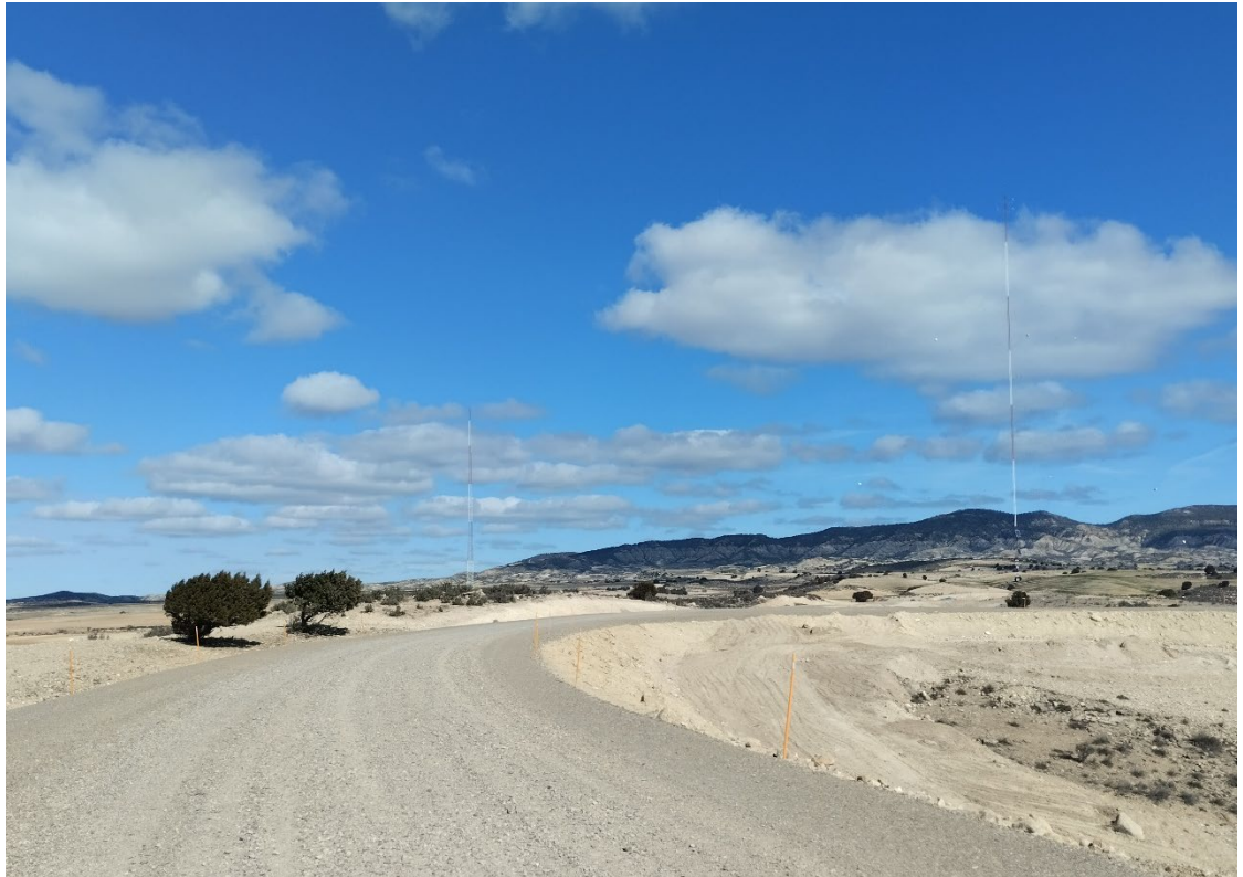
Situación a 29 de febrero de 2024, tras el cuarto mes de obras
