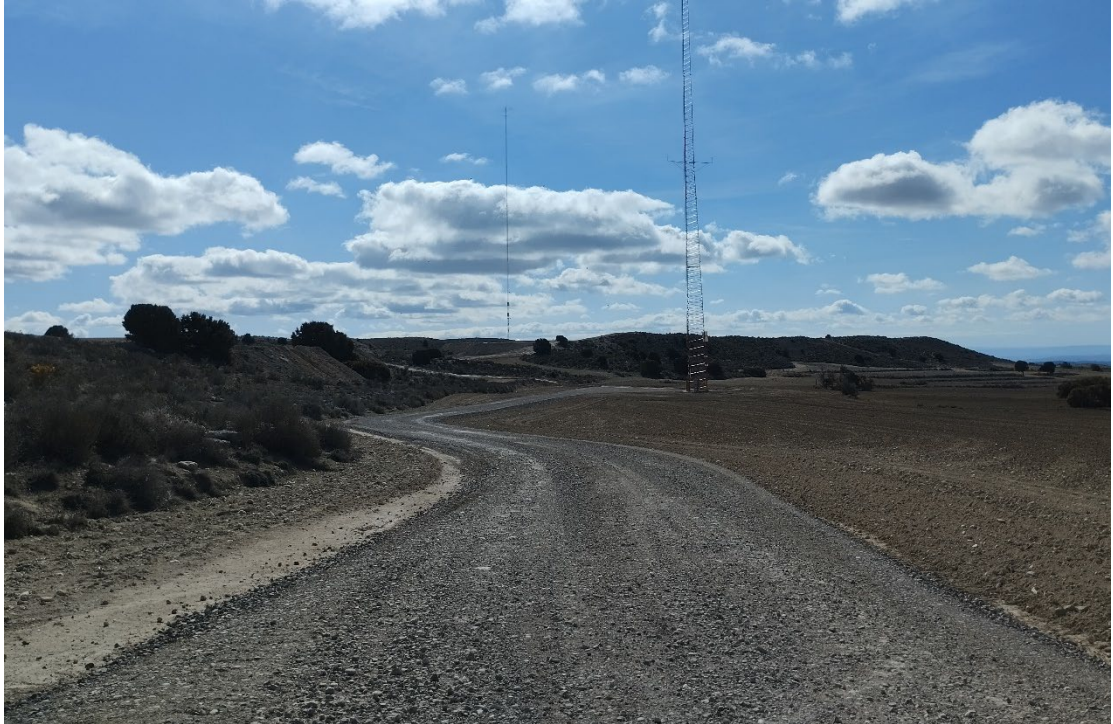
Situación a 29 de febrero de 2024, tras el cuarto mes de obras
