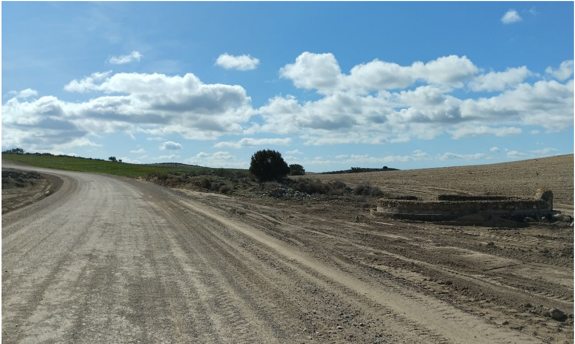
Situación a 29 de febrero de 2024, tras el cuarto mes de obras
