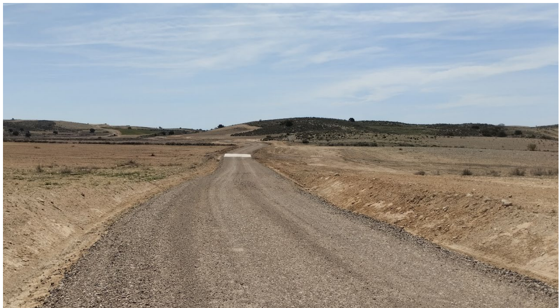
Situación a 4 de abril de 2024, tras el quinto mes de obras
