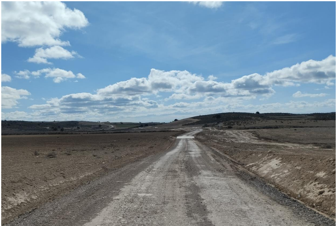
Situación a 29 de febrero de 2024, tras el cuarto mes de obras
