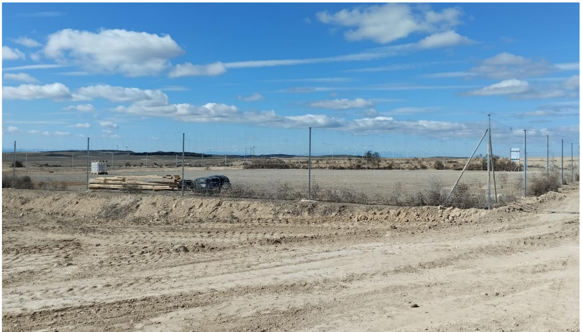
Situación a 29 de febrero de 2024, tras el cuarto mes de obras
