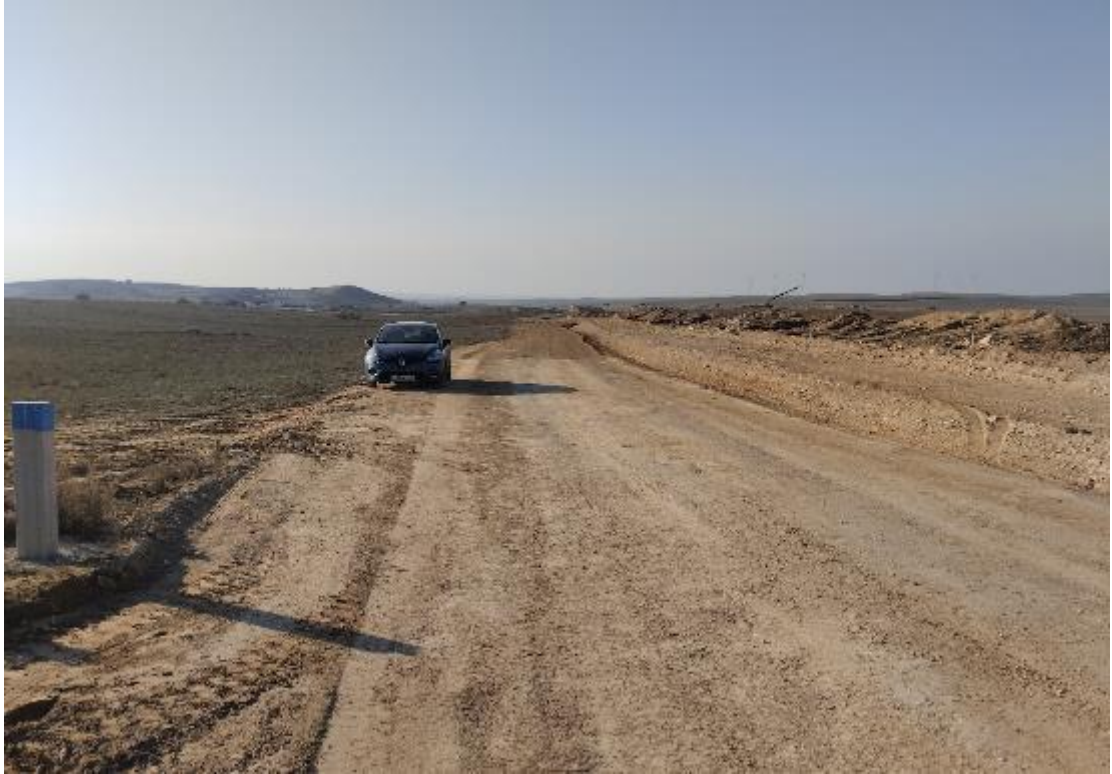
Situación a 31 de enero de 2024, tras el tercer mes de obras
