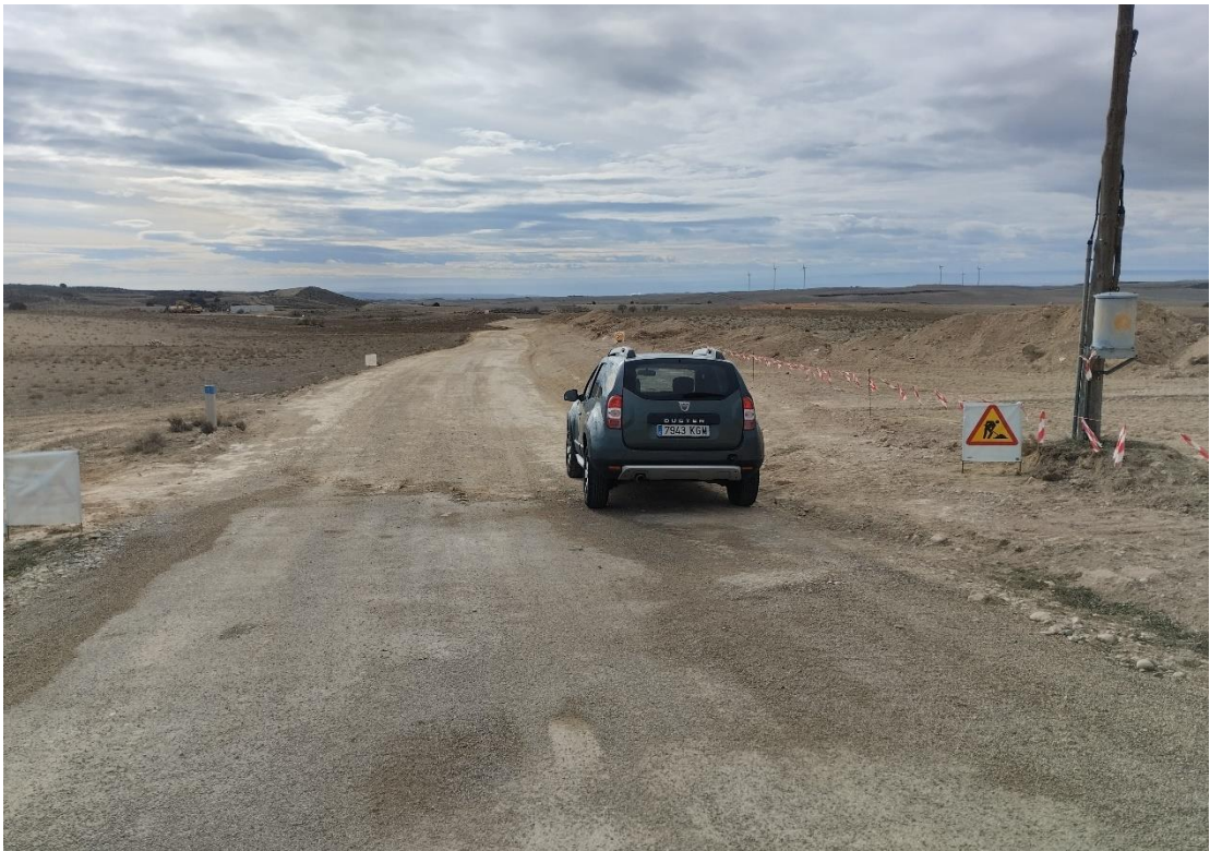
Situación a 28 de diciembre de 2023, tras el segundo mes de obras
