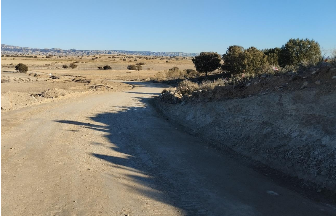
Situación a 28 de diciembre de 2023, tras el segundo mes de obras
