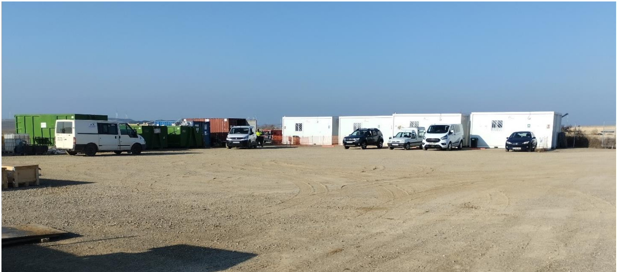
Situación a 31 de enero de 2024, tras el tercer mes de obras
