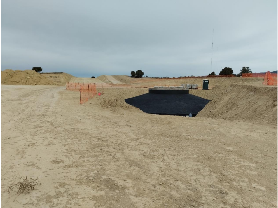
Situación a 28 de diciembre de 2023, tras el segundo mes de obras
