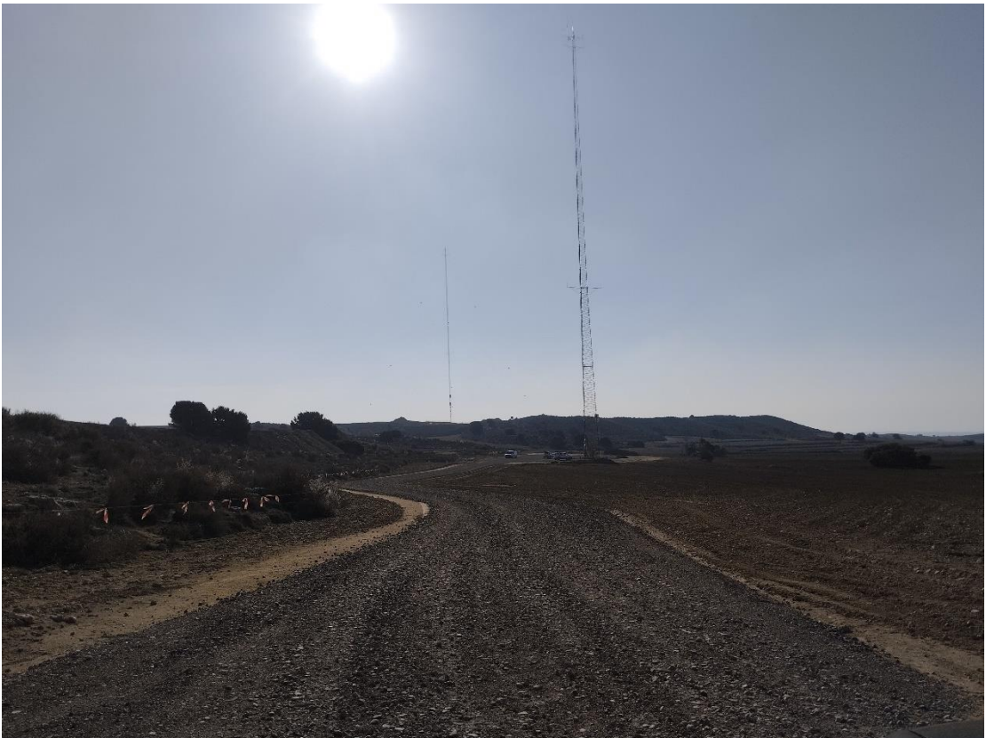
Situación a 31 de enero de 2024, tras el tercer mes de obras
