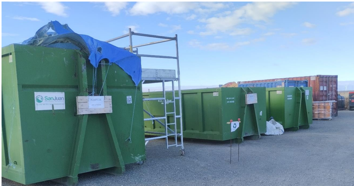
Punto limpio de RNP: situación a 28 de diciembre de 2023, tras el segundo mes de obras
