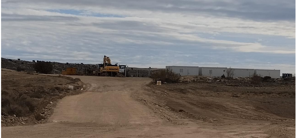
Situación a 28 de diciembre de 2023, tras el segundo mes de obras
