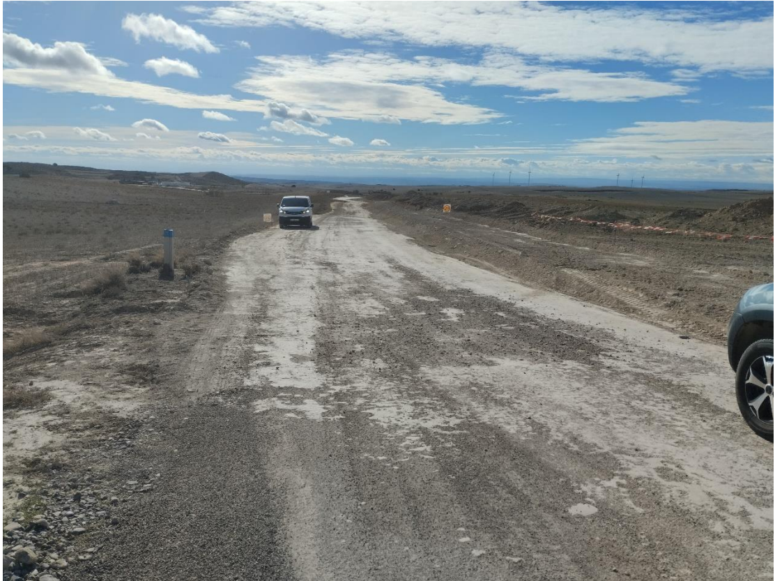
Situación a 30 de noviembre de 2023, tras el primer mes de obras
