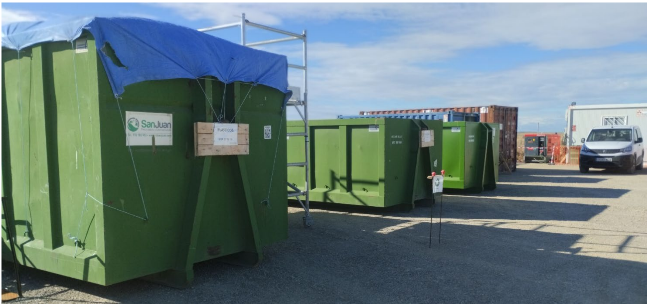
Punto limpio de RNP: situación a 30 de noviembre de 2023, tras el primer mes de obras
