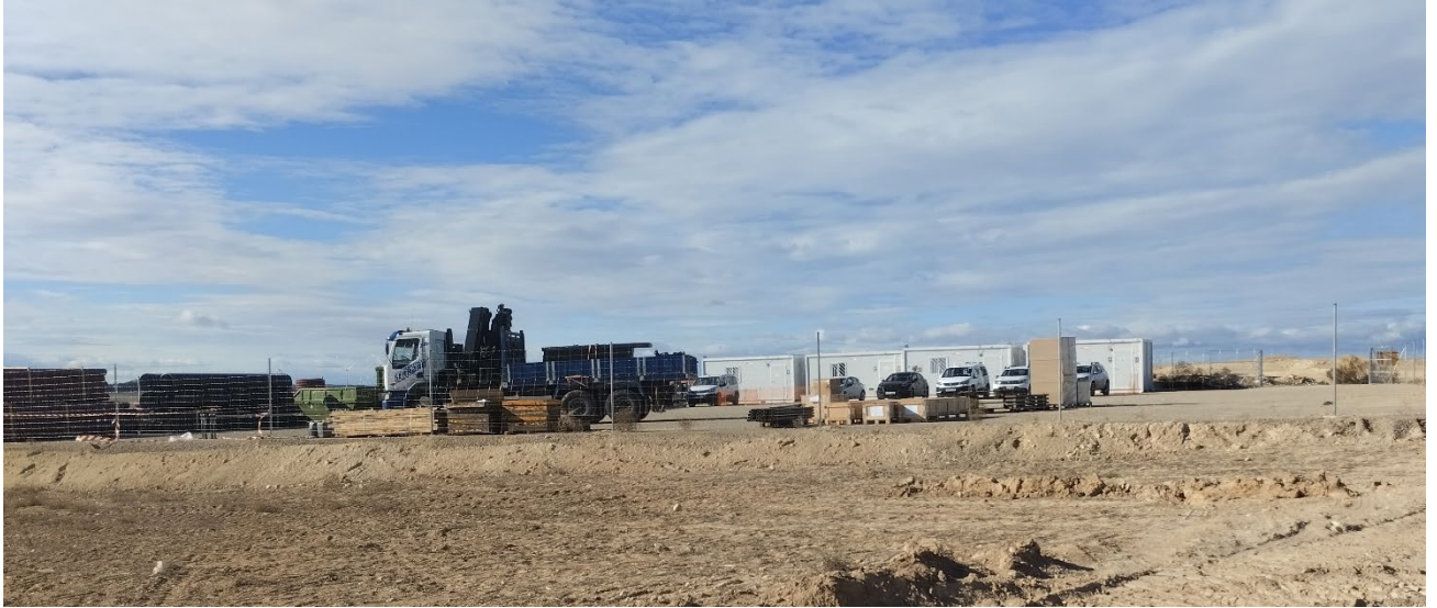
Situación a 30 de noviembre de 2023, tras el primer mes de obras
