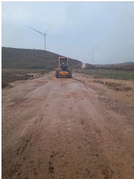
Foto 3. Arreglo de los caminos de acceso al proyecto.
