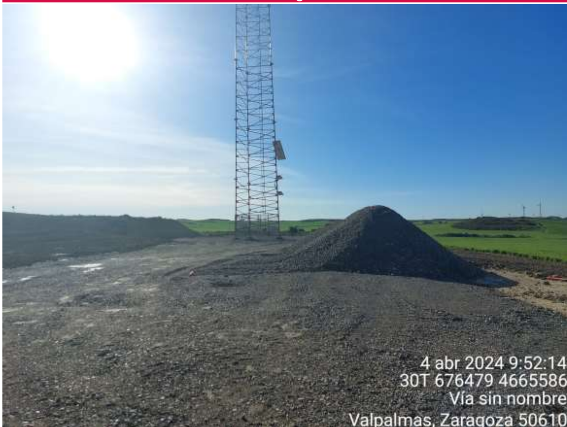
Imagen 1. TM restaurada con zahorra acopiada para extendido.
