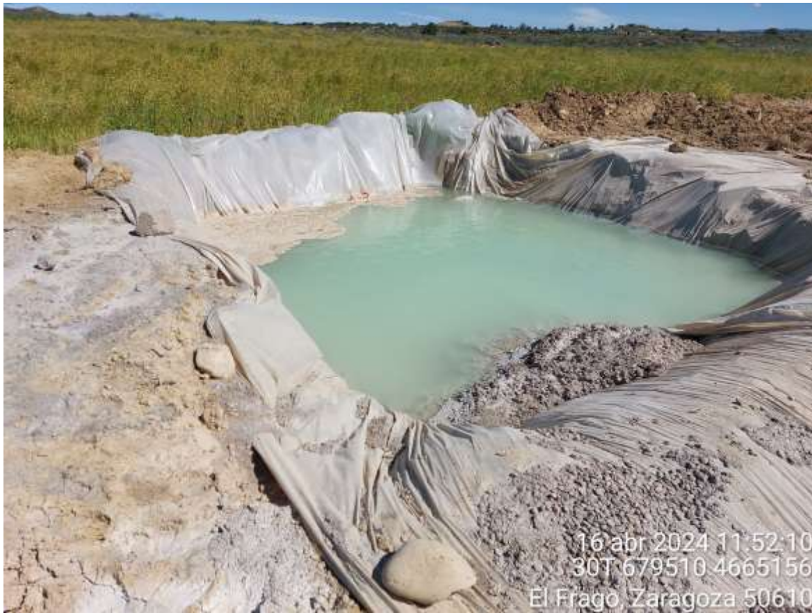
Imagen 1. Pozo de lavado de PAU-04 cumpliendo con el objetivo de protección del suelo.
