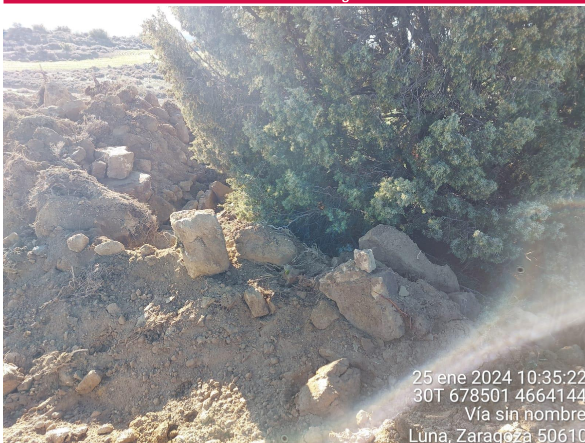
Imagen 1. Ejemplar de Juniperus communis afectado por el cordón de tierra vegetal y material de excavación.
