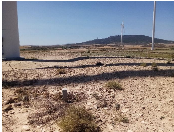
Fotografía 20: Señalización línea subterránea
