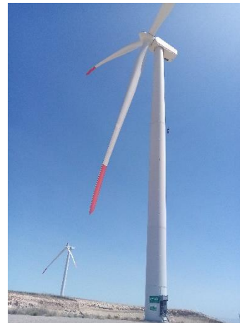
Fotografía 6: Aerogenerador con palas pintadas
