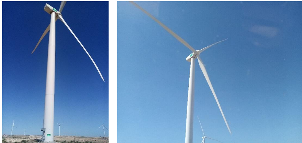
Fotografías 4 a 5: Barquillas de los aerogeneradores sin derrames de aceite
