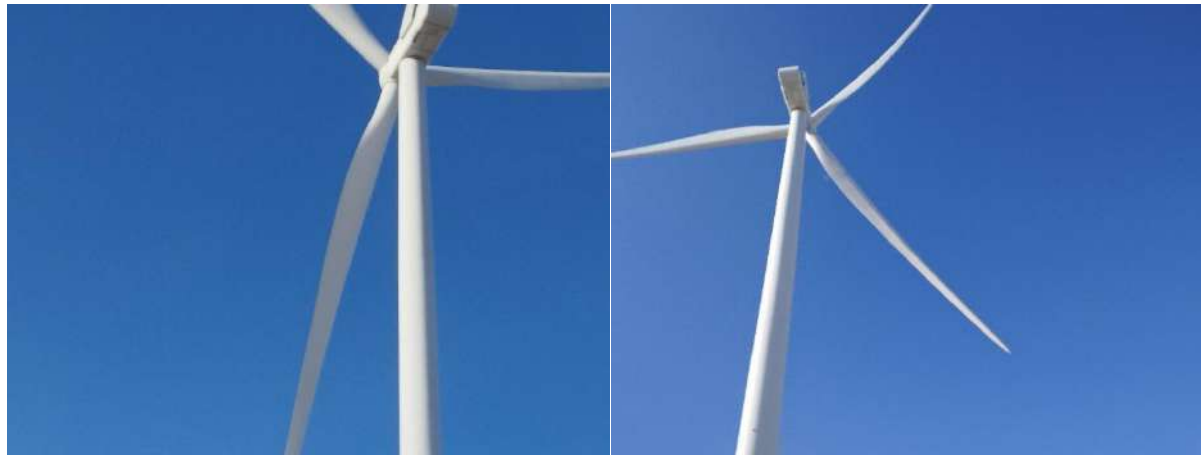
Fotografías 5 a 6: Barquillas de los aerogeneradores sin derrames de aceite
