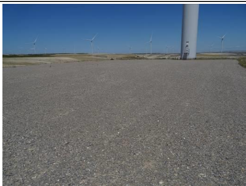
Plataforma aerogenerador A06.
