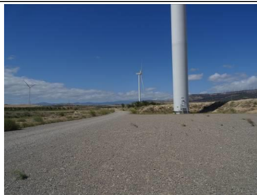
Plataforma aerogenerador A07.
