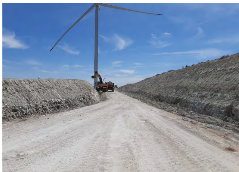
Figura 2: Construcción de cuneta.
