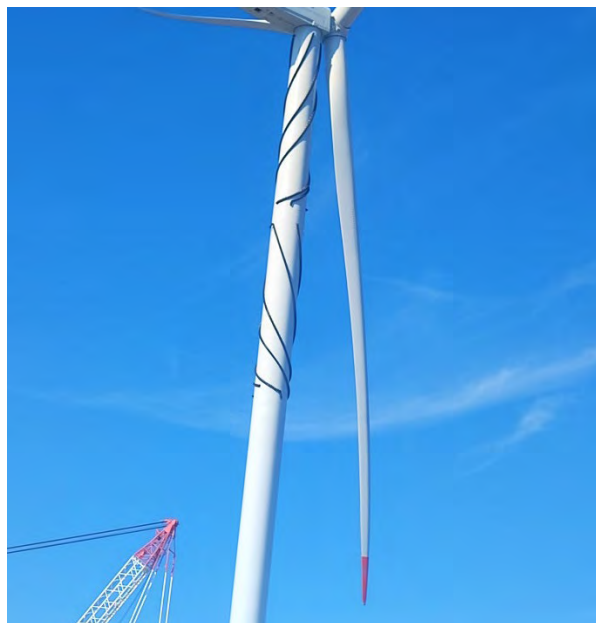
Figura 2: Pintado palas aerogenerador COT-05.
