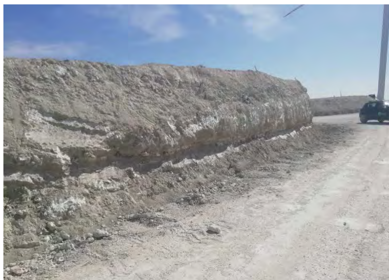
Figura 2: Talud de nueva generación producido por la obra.
