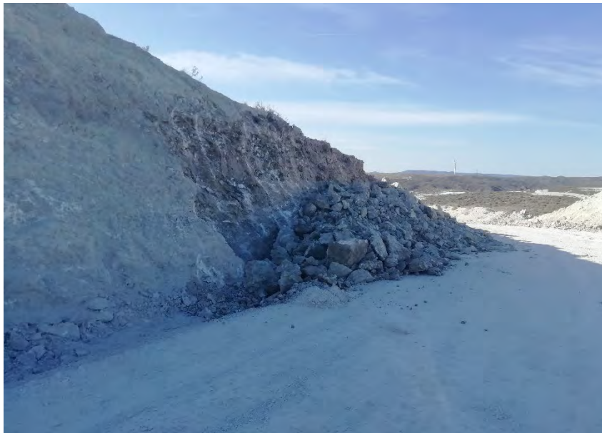
Figura 1: Excedentes de tierra y piedras procedentes de la construcción de cunetas.
