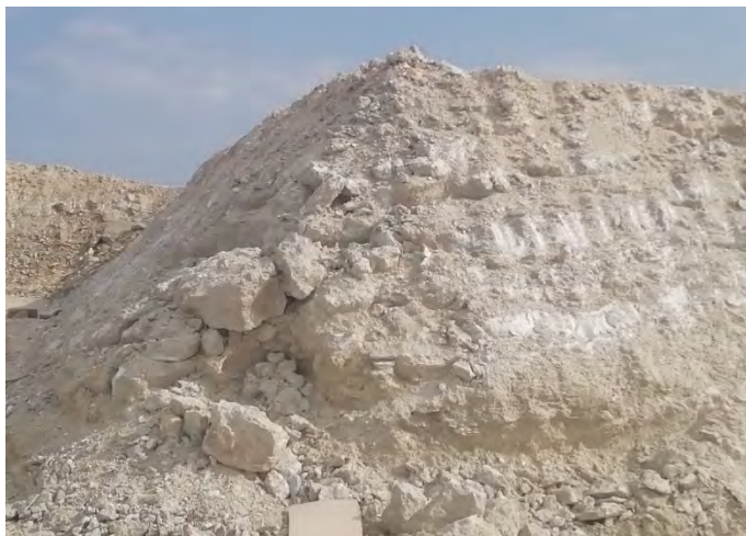
Figura 3: Erosión en talud.
