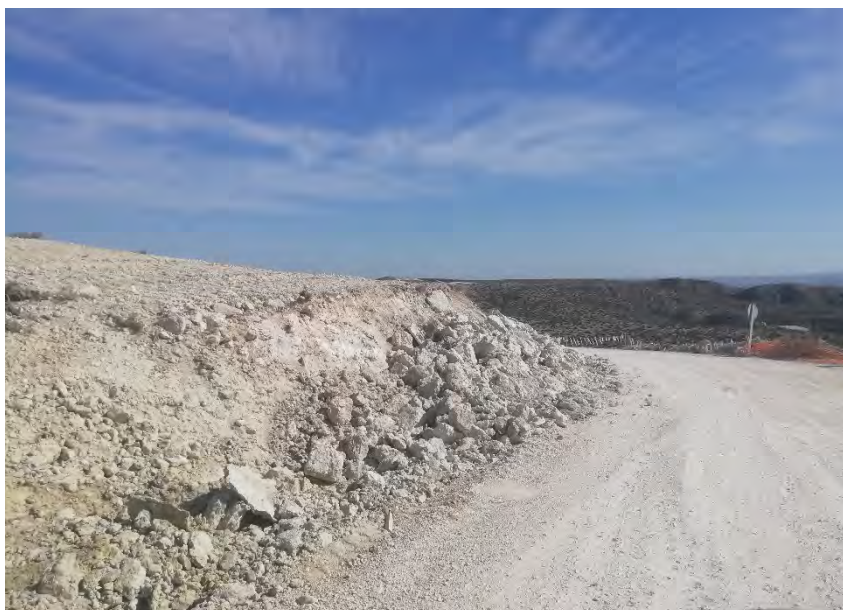
Figura 2: Excedentes de tierra y piedras procedentes de la construcción de cunetas.
