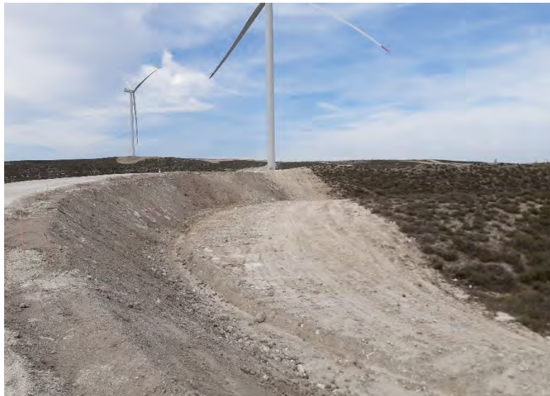
Figura 1: Talud con extendido de tierra vegetal.
