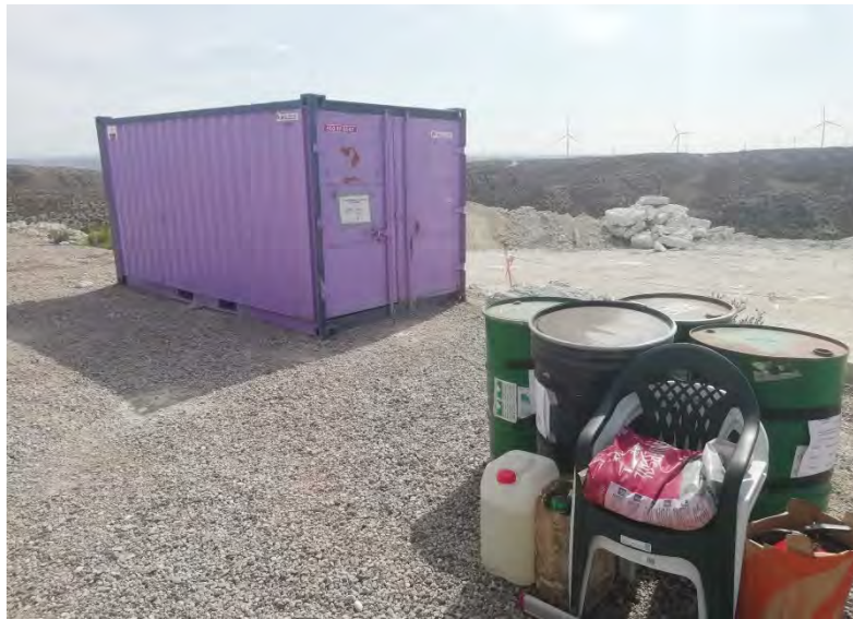
Figura 1: Desmantelamiento punto limpio.
