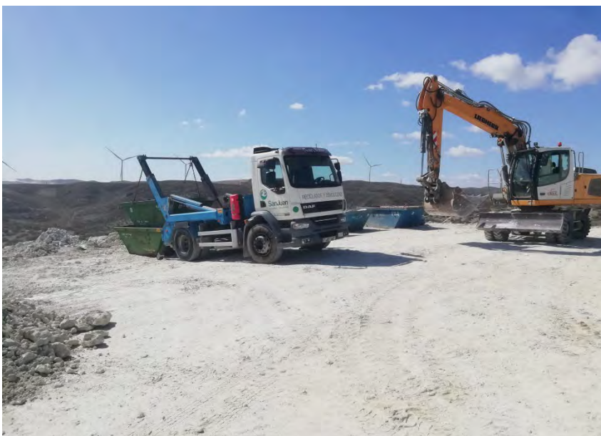
Figura 2: Gestor de residuos realizando la retirada de restos de hormigón.
