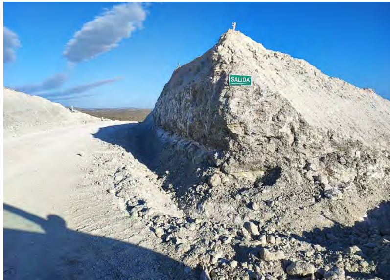
Figura 1: Talud de nueva generación producido por la obra.
