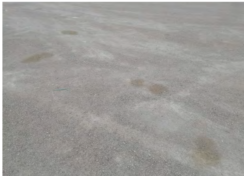
Figura 2: Mancha de líquido contaminante en plataforma de COT-03.
