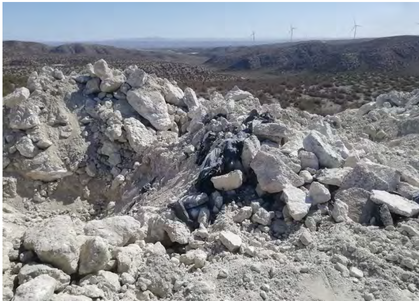
Figura 1: Restos de hormigón en la zona de lavado de cubas.
