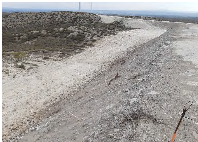
Figura 2: Talud con extendido de tierra vegetal.
