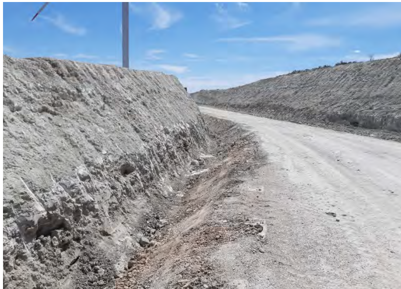
Figura 1: Zona de cuneta.
