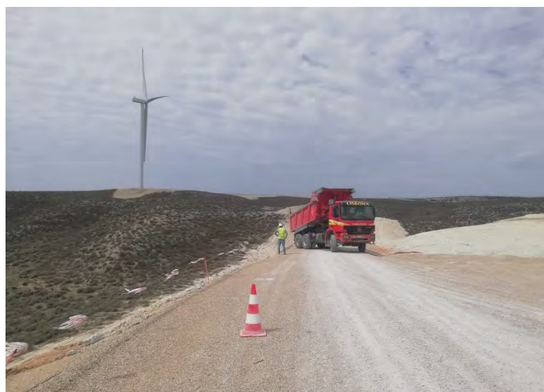
Figura 2: Camión depositando tierra vegetal en el talud.
