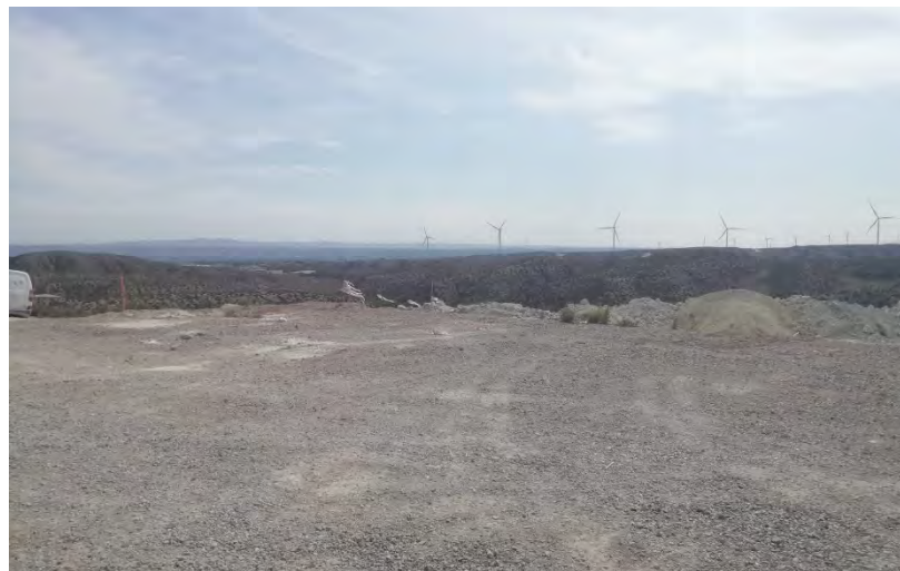
Figura 2: Desmantelamiento punto limpio. Antigua ubicación de contenedores.
