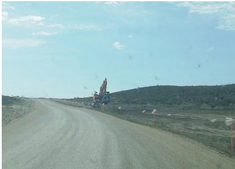
Figura 1: Retirada de acopios de tierra vegetal.
