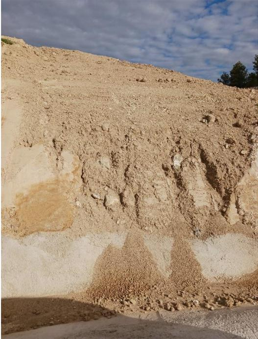
*Figura 2: Erosión en la CAM-15*
