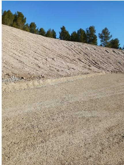
*Figura 1: Restitución en CAM-01 y ejecución de cuneta*
