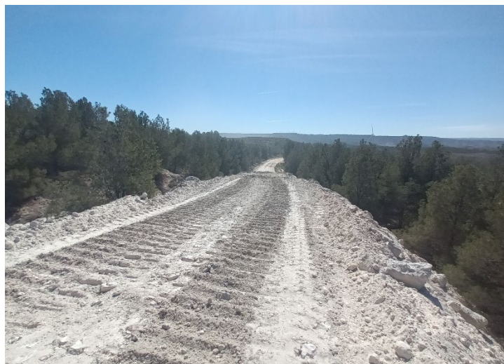
Figura 2: Inicio restitución en vial aledaño a CAM-03
