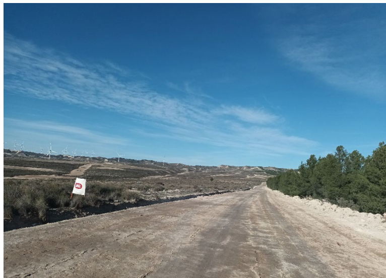
Figura 2: Evidencia de riego y cuba de riego
