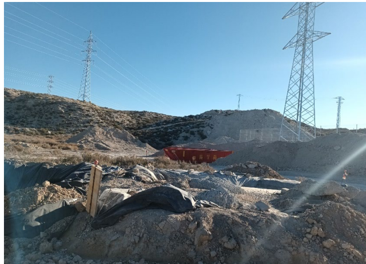
Figura 1: Balsa de limpieza de hormigón llena y contenedores para vaciado
