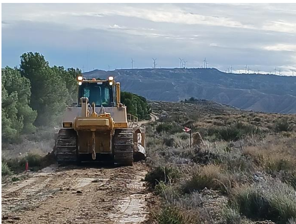
Fig. 3 Desbroce mecánico en el entorno del Mojón 10
