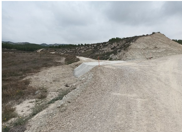
Figura 1: Vado y hormigonado de talud entre camino rural y vial principal
