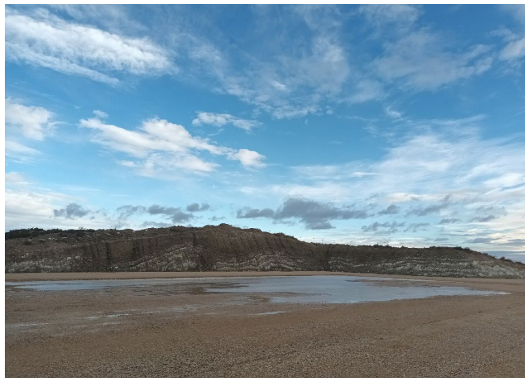
Figura 4: Agua en la plataforma de CAM-12, sin afección a la cimentación
