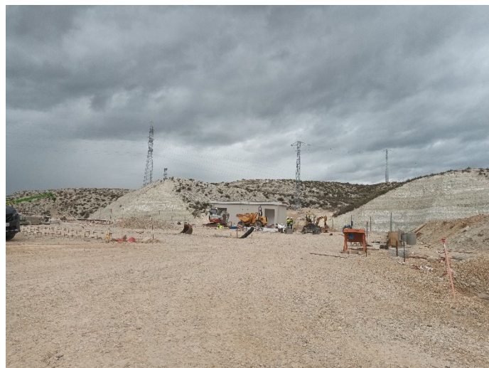
Figura 2: Edificio SET ENDESA
