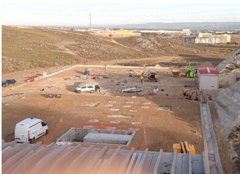
Figura 2: Detalle cuneta perimetral hasta el edificio de endesa
