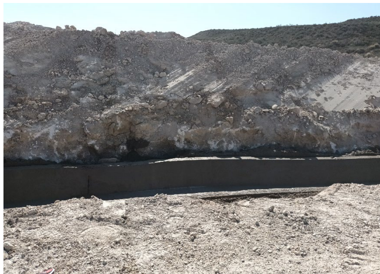
Figura 2: Hormigonado de cunetas
