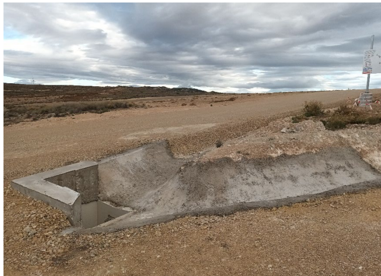
Figura 1: Cuneta acceso a CAM-02
