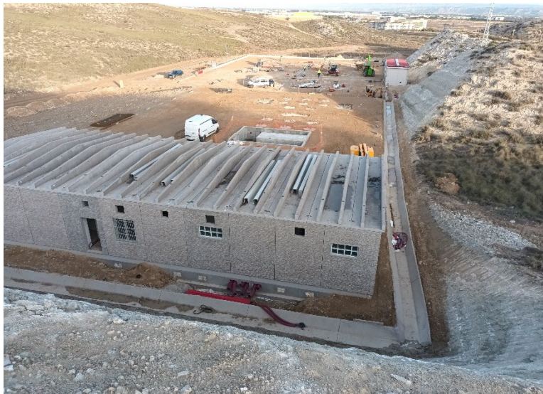
Figura 1: Cuneta perimetral SET CAMPILLO
