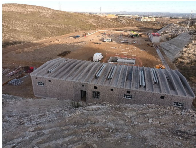
Figura 1: Avance montaje edificio SET CAMPILLO
