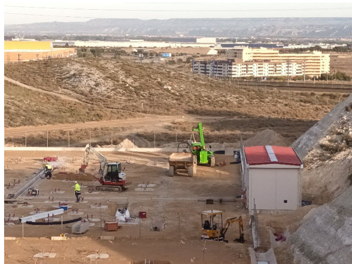
Figura 2: Edificio SET ENDESA
