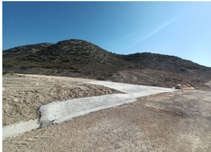
Figura 1: Hormigonado acceso a vial y cuneta
