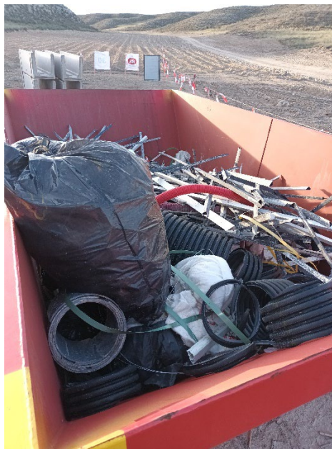
Figura 1: Punto limpio de RNP en la zona de la SET Campillo
