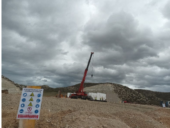
Figura 3: Montaje edificio SET Campillo
