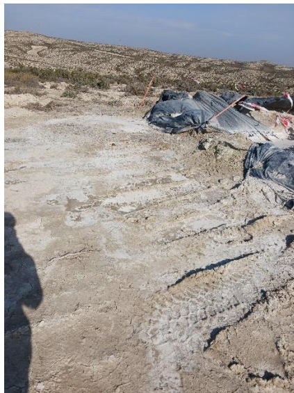
Fig 4. Balsa de limpieza en aerogenerador 12
