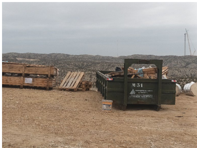
Figura 2: Zona de casetas al lado de CAM-03 desordenado
