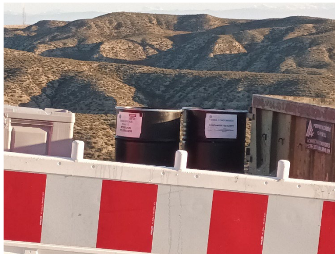
Figura 4: Contenedores de residuos peligrosos sin cubrir ni aislar en CAM-03
