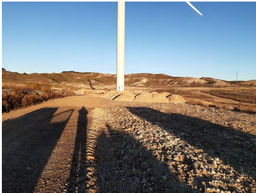
Figura 2. Estado actual de la plataforma de CA-03.
