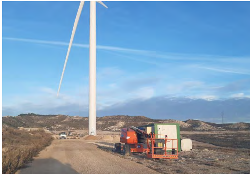
Figura 1. Trabajos de revegetación en CA-03.
