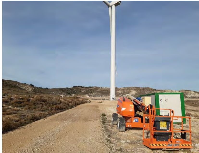
Figura 1. Trabajos relacionados con la revegetación en CA-03.
