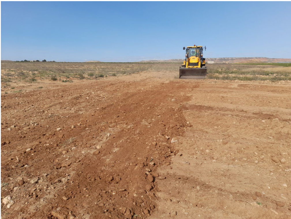
Fig. 1 Desbroce y adecuación de instalación acopio temporal
