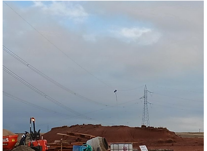
Figuras 1 y 2: Instalación de balizas salvapájaros en el último tramo que queda pendiente en la LAAT.
