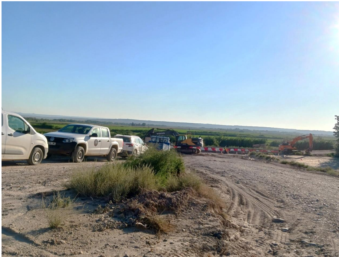
Figura 1: Acceso cortado por trabajos en la zanja.
