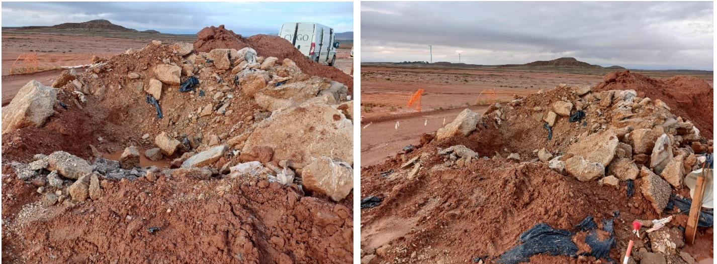
Figuras 1 y 2: Antigua balsa de limpieza de hormigón sin dismantelar todavía.
