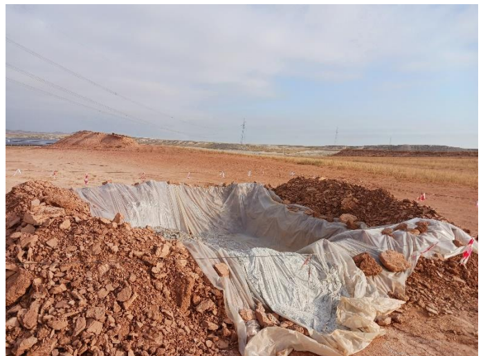
Figuras 2 y 3: Nueva balsa de limpieza de hormigón habilitada y señalizada correctamente.
