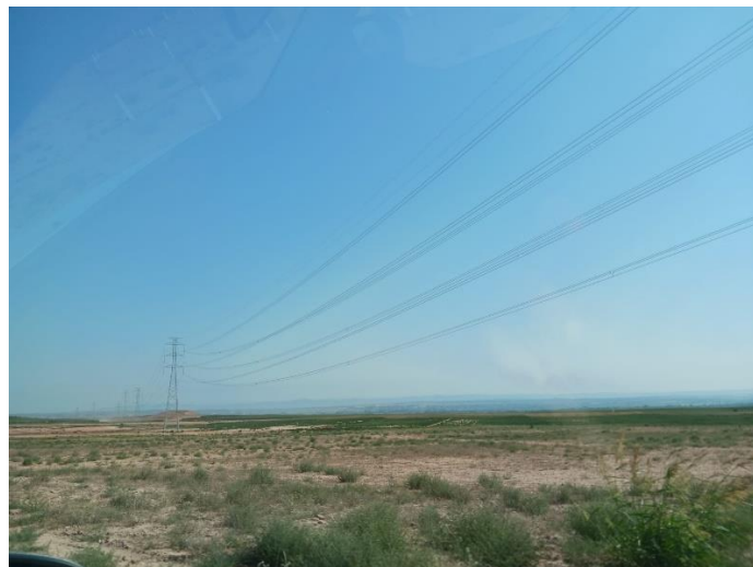
Figuras 1, 2 y 3: Cableado de la LAAT extendido sin salvapájaros.
