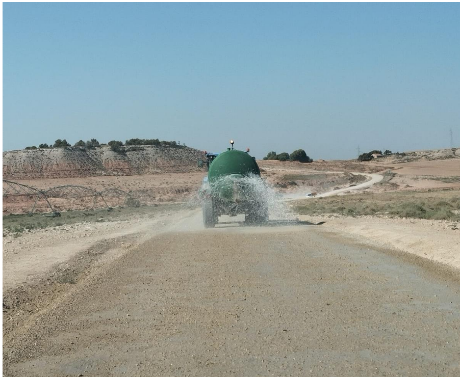
Figura 1: Riego de viales en obra.
