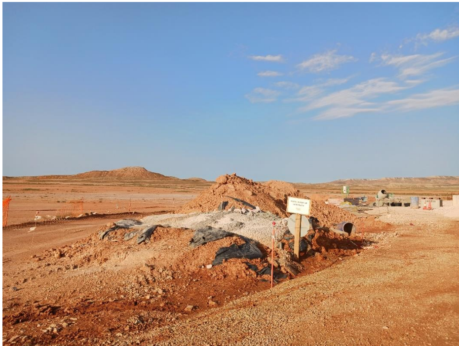
Figura 1: Antigua balsa de limpieza de hormigón sin dismantelar.
