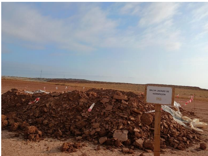
Figuras 2 y 3: Nueva balsa de limpieza de hormigón habilitada y señalizada correctamente.
