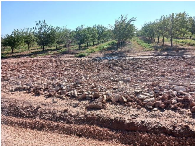
Figuras 3 y 4: Tramos de la zanja cubiertos con excesiva pedregosidad.
