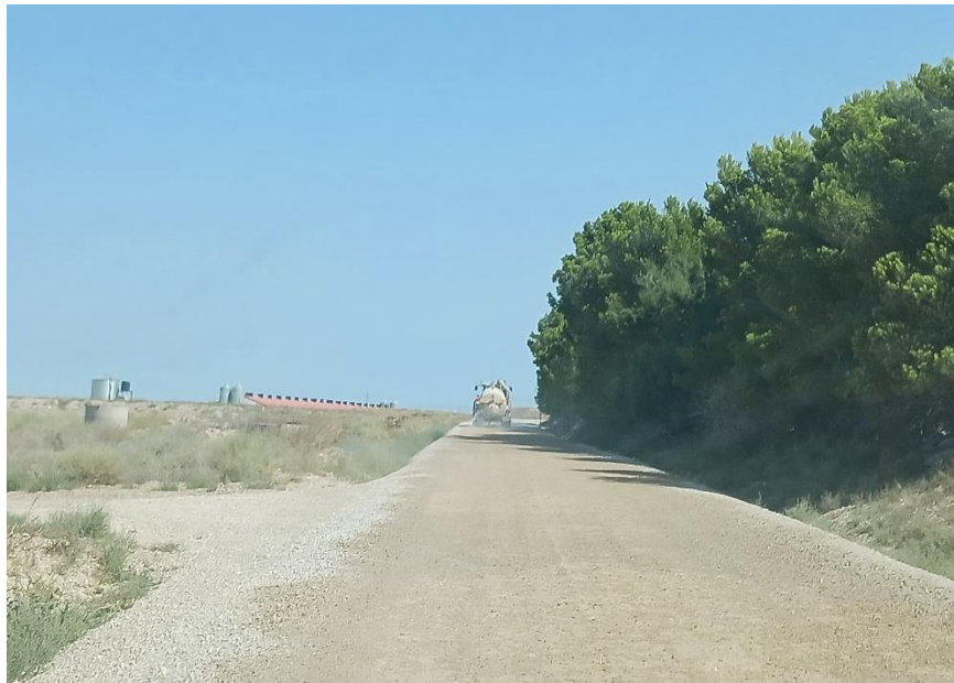
Figura 1: Riego de viales en obra.
