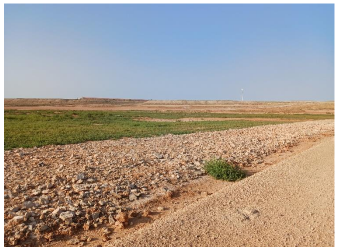
Figuras 3 y 4: Tramos de la zanja cubiertos con excesiva pedregosidad.
