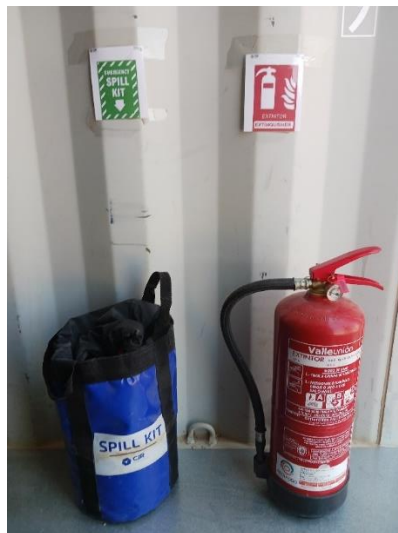
Figura 1: Extintor y Kit batefuegos señalizados y en correcto estado, almacenados en el Punto limpio de Residuos Peligrosos.
