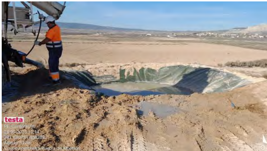
Pozo de lavado de hormigón en CNII-11
