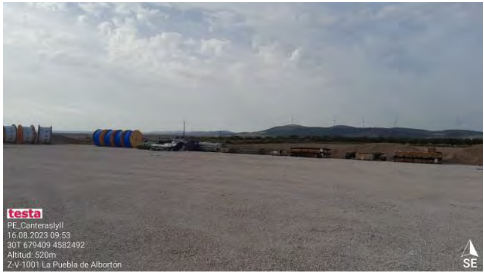
Campa de acopio sin contenedores.
