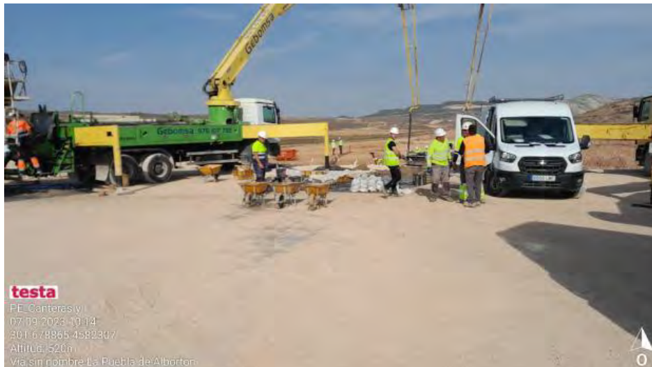
Hormigonado de CNII-8
