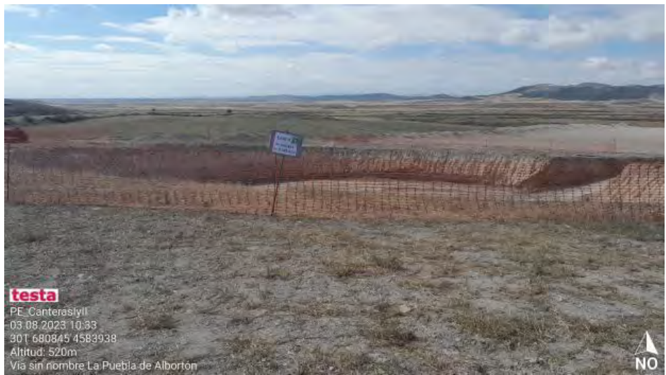
Excavación en CNTII-11
