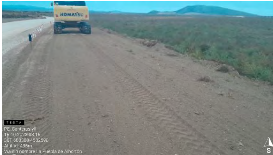
Zanja de evacuación
