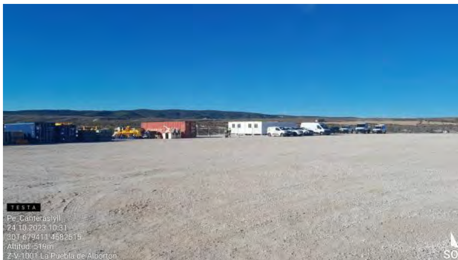
Instalaciones de oficinas y punto limpio de nueva contrata en campa .
