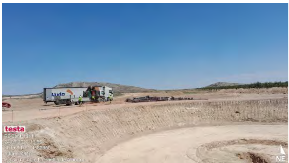
Preparación para hormigonado de limpieza en CNII-13
