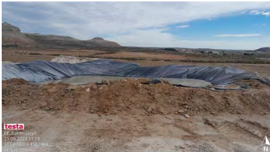
Pozo de lavado de hormigón en CNII-1
