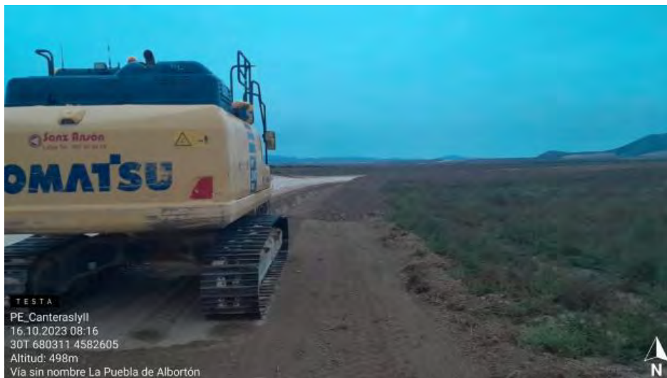
Trabajos en zanja de evacuación
