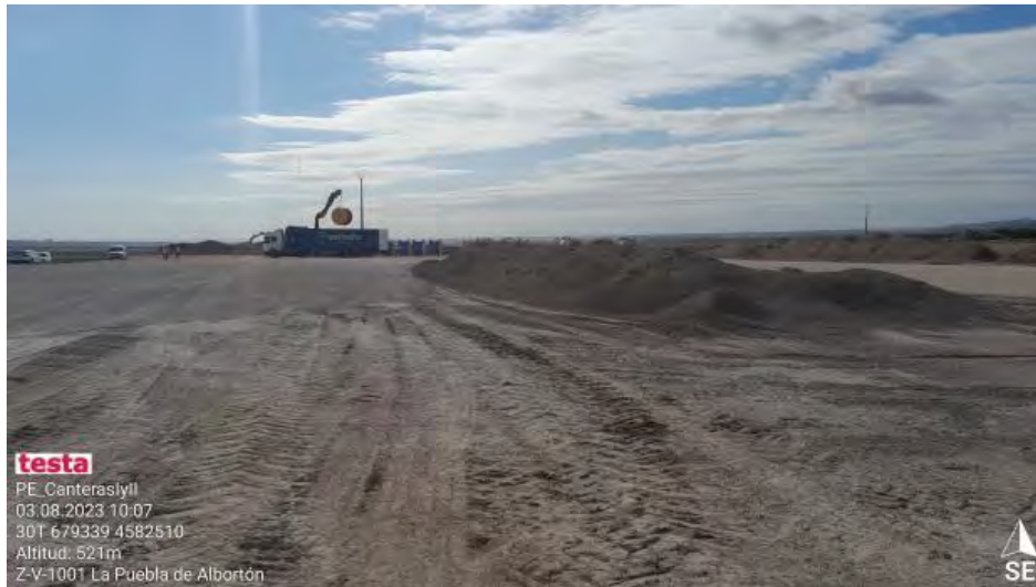
Campa de acopio.
