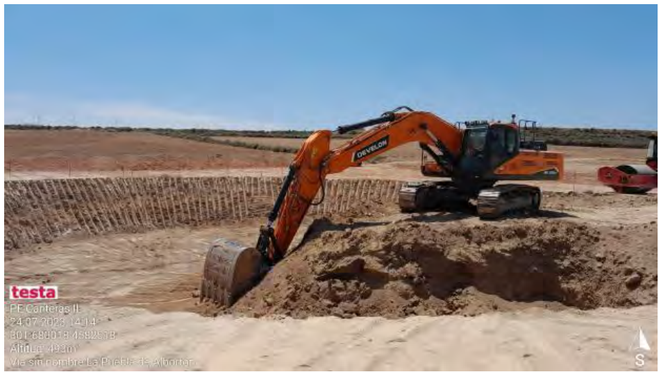
Excavación en CNII-9
