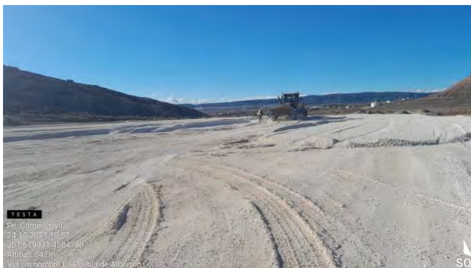
Trabajos con zorra en plataforma
