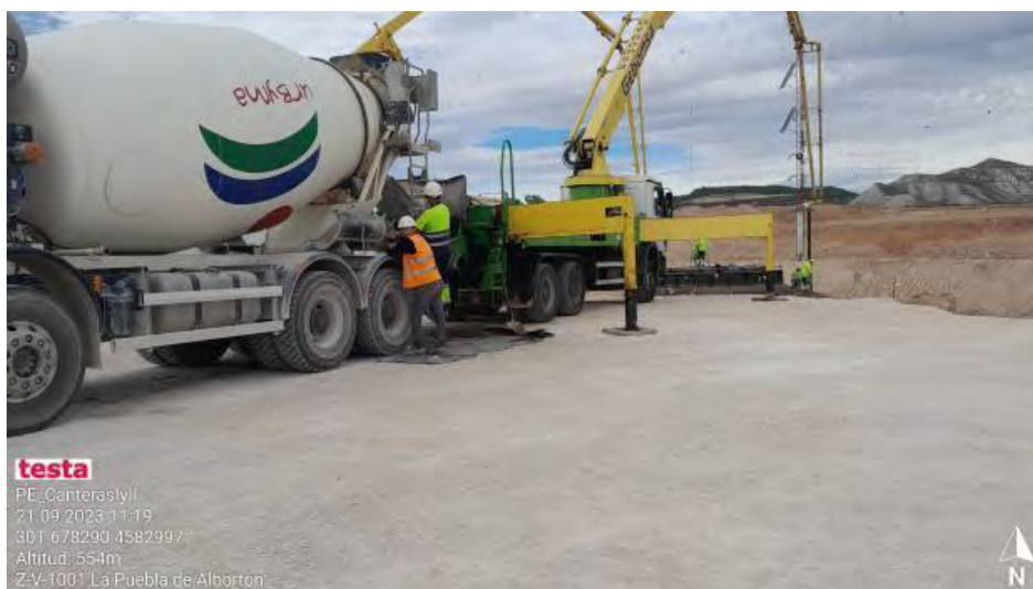
Hormigonado en CNII-1
