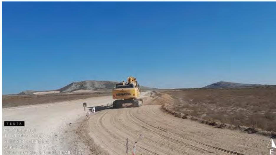
Trabajos en zanja de evacuación
