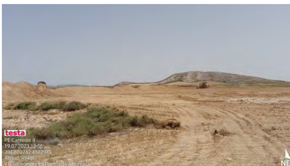
Trabajos y desbroces en CN2-13
