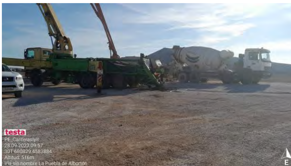
Hormigonado en CNII-11
