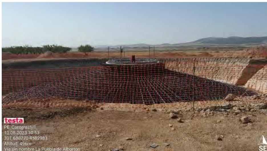
CANII-12 a la espera de hormigonado.
