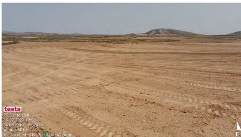
Estaquillado y primeros trabajos en CN2-9
