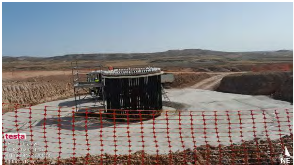
Trabajos en CNTII-9
