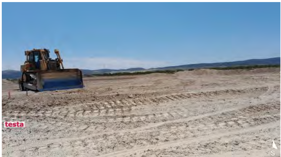
Desbroce en campa de acopio
