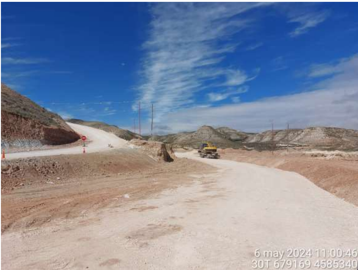
Imagen 1. Maquinaria realizando movimiento de tierras. Prohibición de subida a CNT1-02
