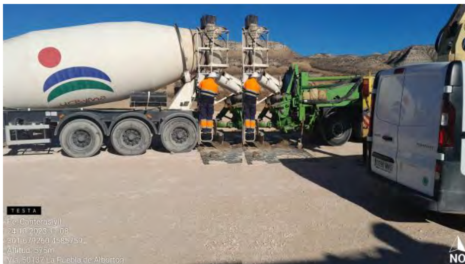
Hormigonado en CN1-9
