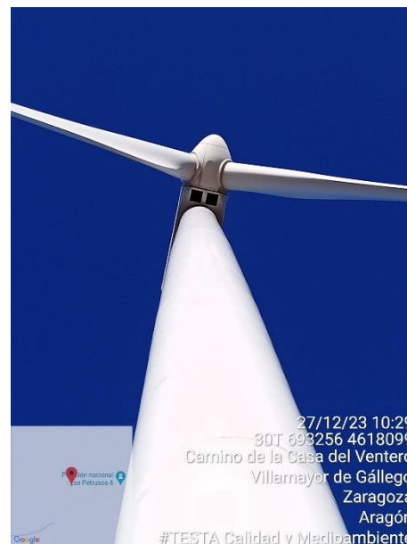
Fotografías 4 a 5: Barquillas de los aerogeneradores sin derrames de aceite
