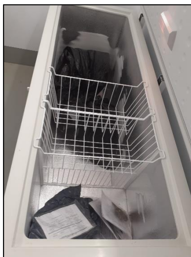
Fotografía 1. Arcón congelador del parque eólico
