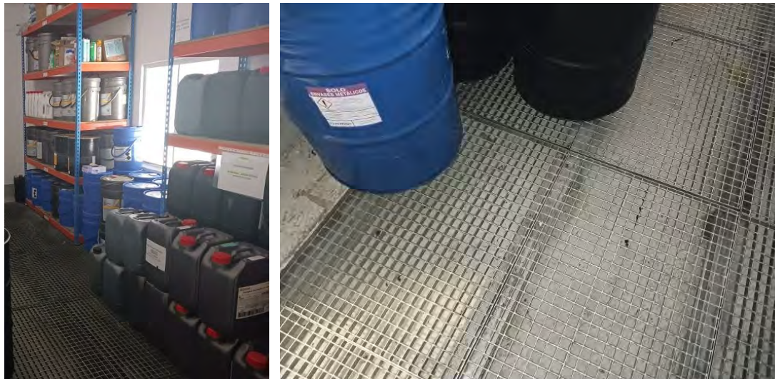
Fotografías 9 a 10: Almacenamiento de residuos y bidones sobre rejilla de contención
