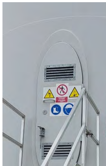
Fotografía 8: Señalización de las torres de los aerogeneradores
