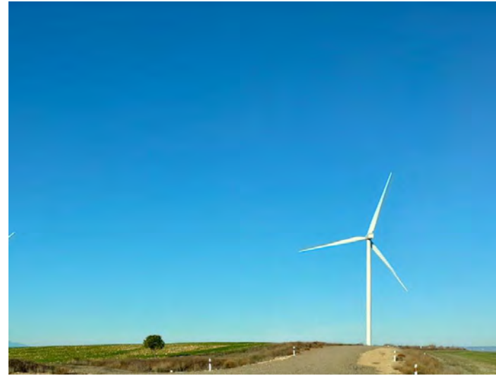
Fotografías 4 y 5: Estado de los caminos y viales
