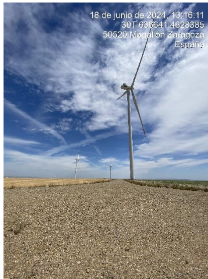
Figura 14: Viales pertenecientes al aerogenerador CDM-03.
