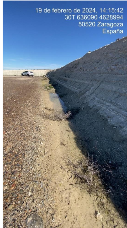
Figura 9: Conductos de drenaje colmatados por la tierra que ha sido arrastrada tras las precipitaciones. Fotografía izq., vial y fotografía derecha plataforma del aerogenerador CDM-02.
