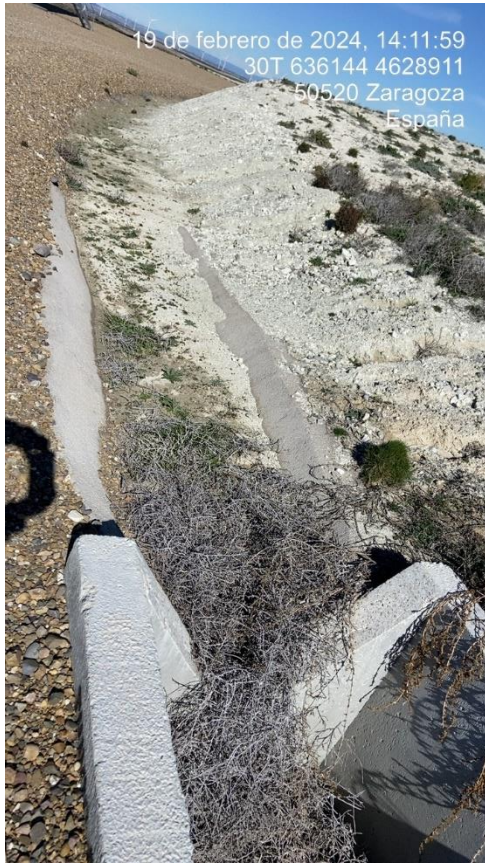
Figura 9: Conductos de drenaje colmatados por la tierra que ha sido arrastrada tras las precipitaciones. Fotografía izq., vial y fotografía derecha plataforma del aerogenerador CDM-02.
