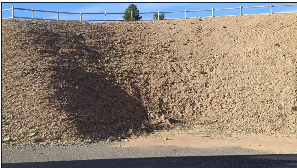
Figura 12: Estado de los taludes, con revegetación natural muy tímida y las plantas de la hidrosiembra secas.
