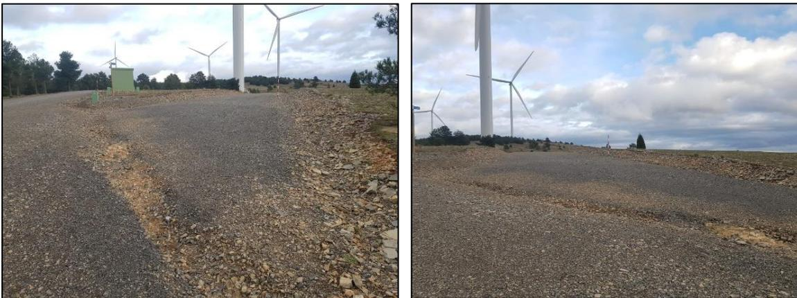
Figura 13: Riera formada en la entrada al vial de acceso al Aerogenerador APE-01 en el parque eólico “Ampliación Puerto Escandón”.
