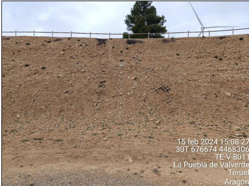
Figura 11: Geomalla textil descubierta de forma puntual y pequeña colada sedimentaria depositada en la plataforma del aerogenerador APE-03
