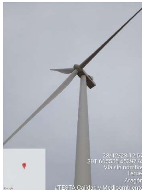
Fotografías 3 a 4: Barquillas de los aerogeneradores sin derrames de aceite
