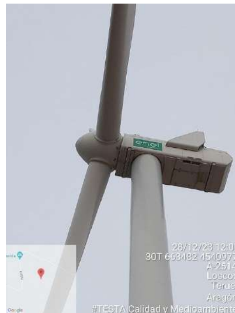
Fotografías 3 a 4: Barquillas de los aerogeneradores sin derrames de aceite
