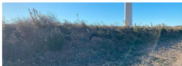
Estado general de los taludes restaurados (AG-04)
