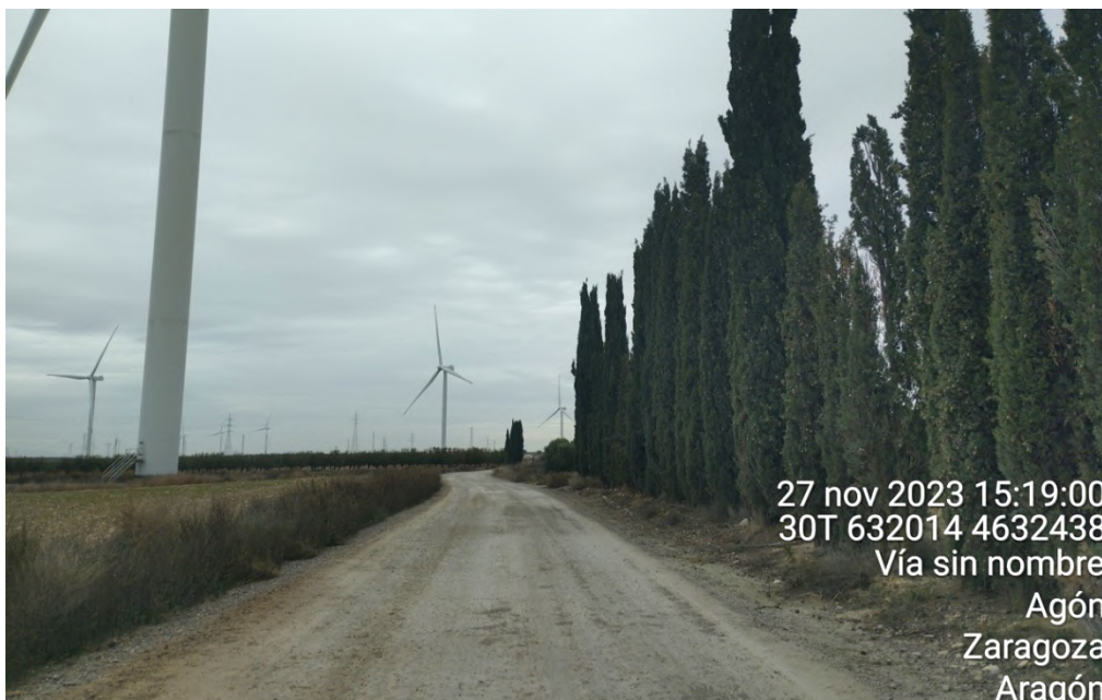
Figura 36: Vial principal de acceso a AG-03.
