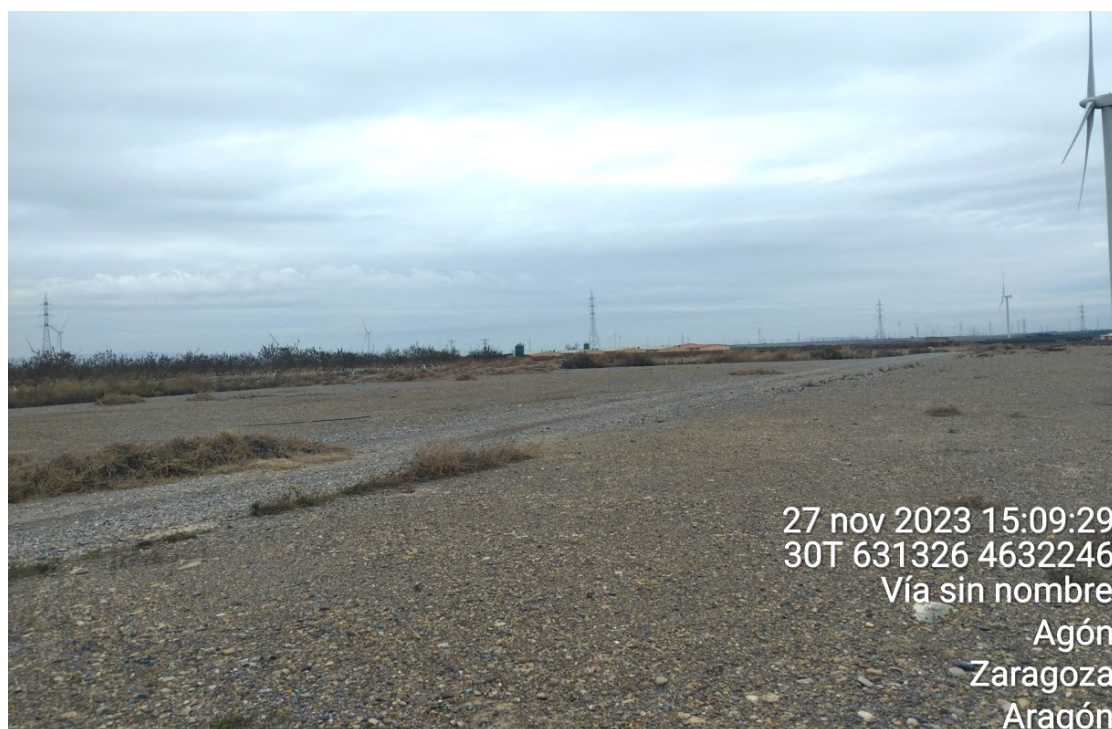
Figura 39: Estado de la plataforma de AG-02.
