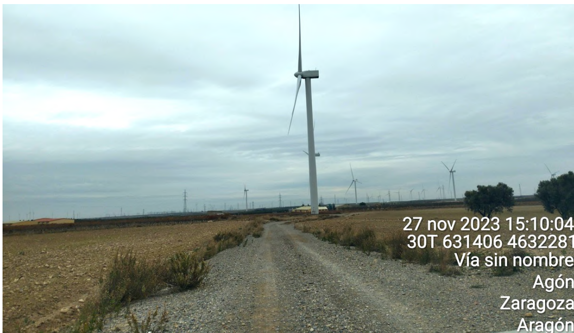
Figura 38: Vial de acceso entre AG-01 y AG-02.
