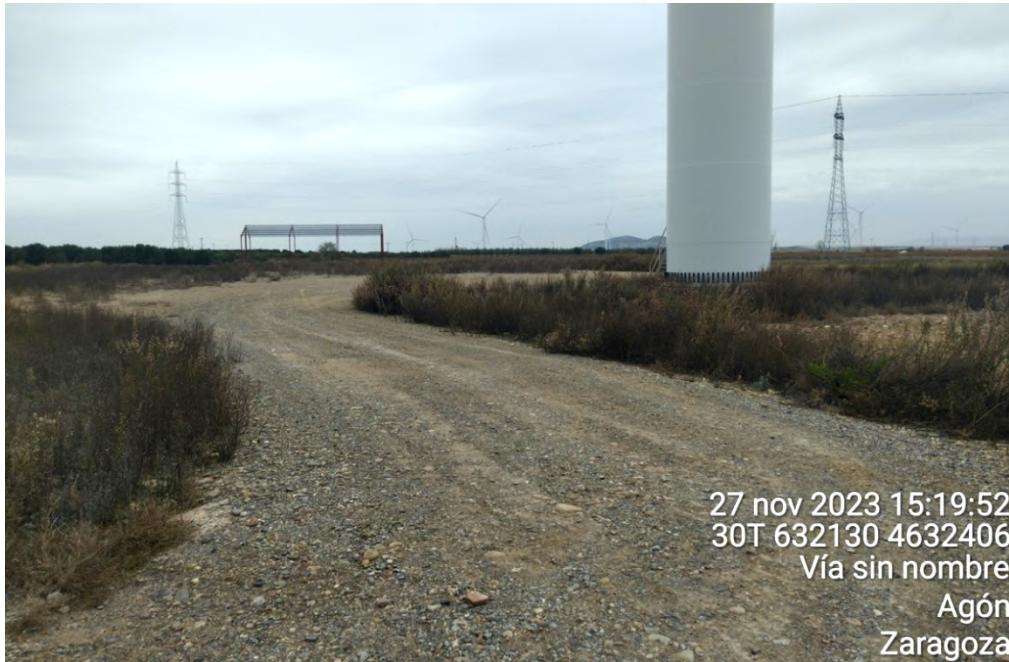
Figura 34: Área restaurada entorno a plataforma de AG-03, puede observarse vegetación natural desarrollándose en la superficie restaurada, así como en parte de la plataforma. Se ha recomendado el desbroce de ésta vegetación natural.
